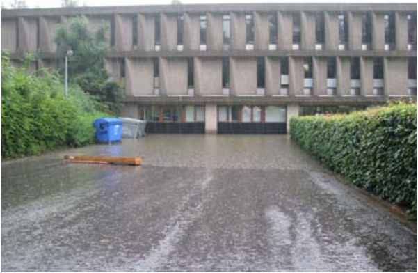
2008 U Liège : inondation de la route vers la porte d'accès aux magasins de bibliothèque (55 litres/m 2 /h)
