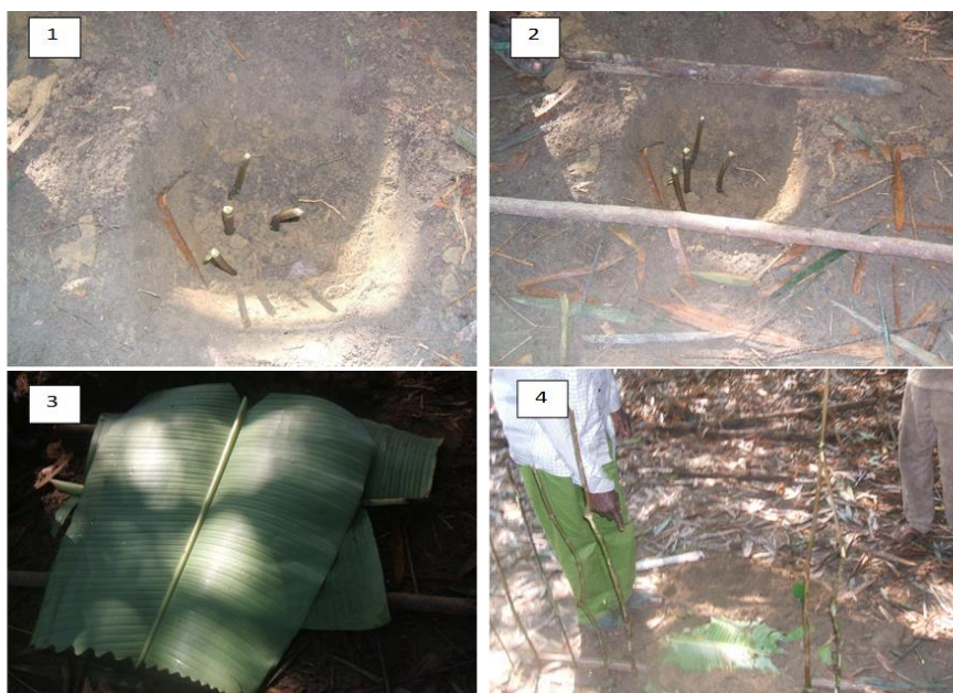
L'illustration de la construction d'une fosse armée, focus-group, village Bafake1, novembre 2016. Photos Billy K.
