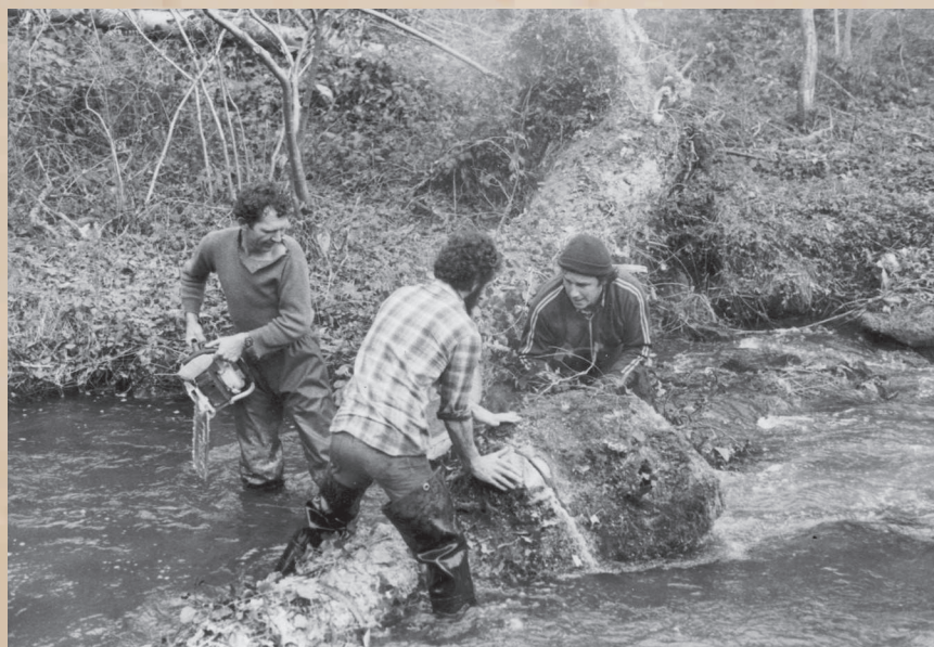
Après l'ouragan de 1987 et les dégâts considérables qu'il a causés, chantier sur le Ster-gozh, en sud Finistère.
