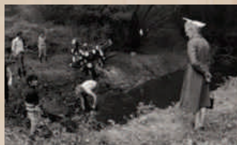
Inspection du chantier...
