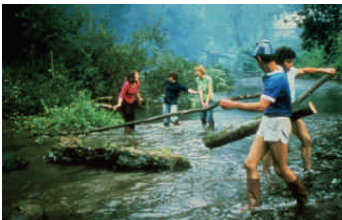
Chantier sur l'Elorn en 1976.
