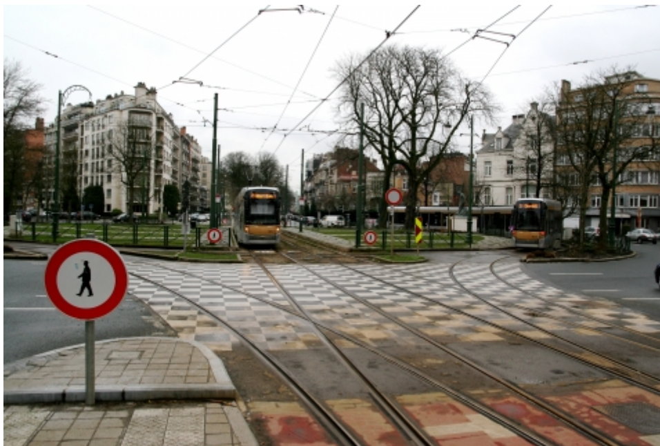
Figure 2. Un exemple de rupture de charge perçue comme inutile par l'usager car située au milieu d'une infrastructure de tramway continue et en dehors de toute possibilité de correspondance transversale (rond-point Churchill à Bruxelles)
