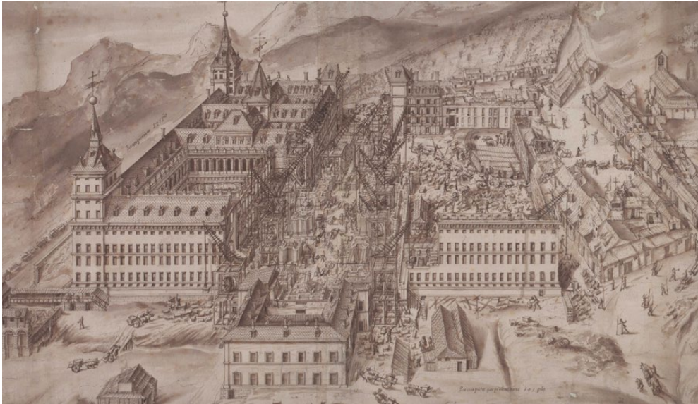
Fig 1. Perspective aérienne – construction du bâtiment du monastère de l'escorial, Collection de Lord Salisbury, Hatfield House, Hertfordshire, Royaume-Uni (vers 1567).
