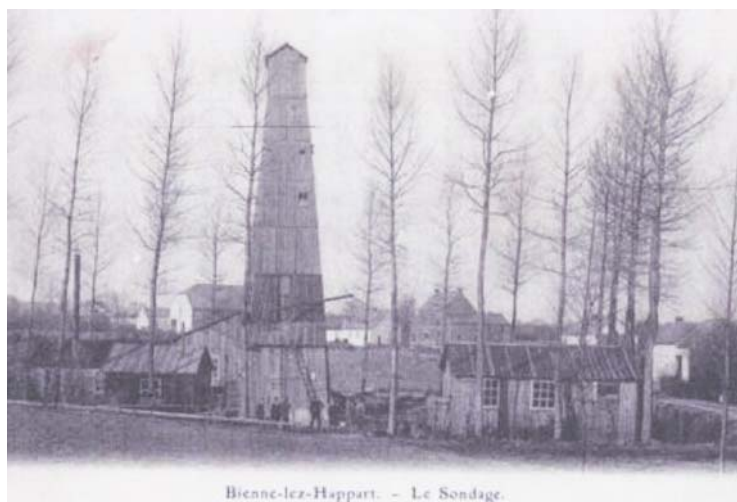
Figure 4 : Ancien sondage minier à Bienne-lez-Happart
