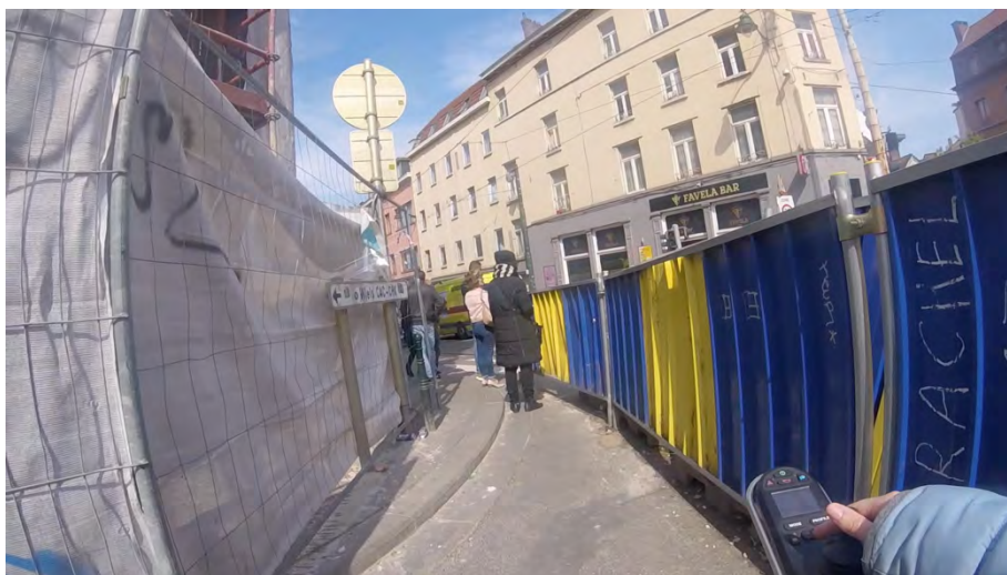
Fig.135 : Emprise des travaux et bordure problématique.
