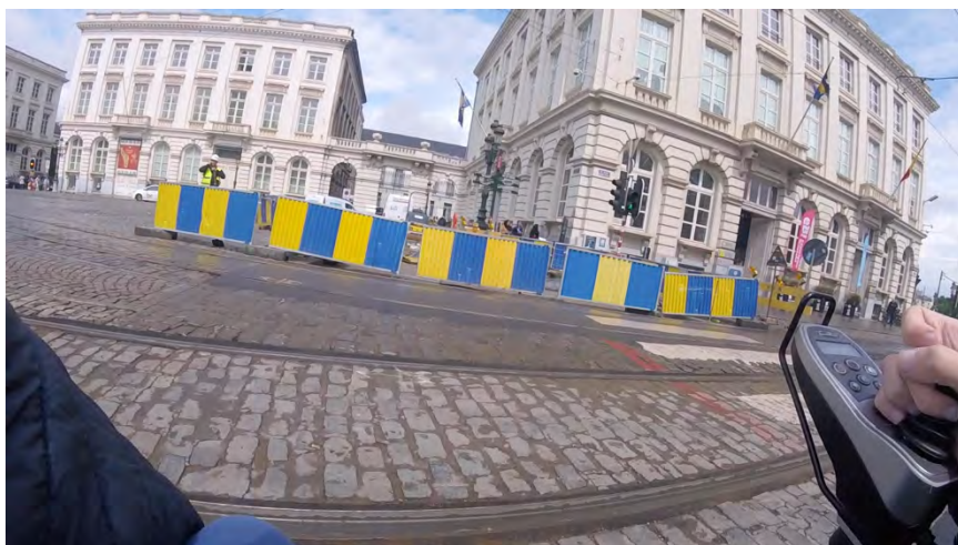
Fig.133 : Revêtement de la Place Royale.
