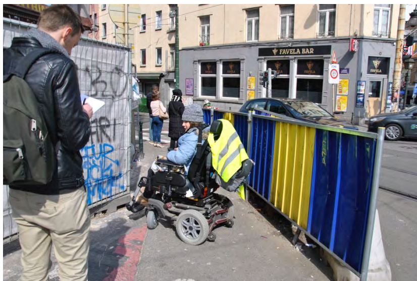
Fig.136 : Emprise des travaux et bordure problématique.
