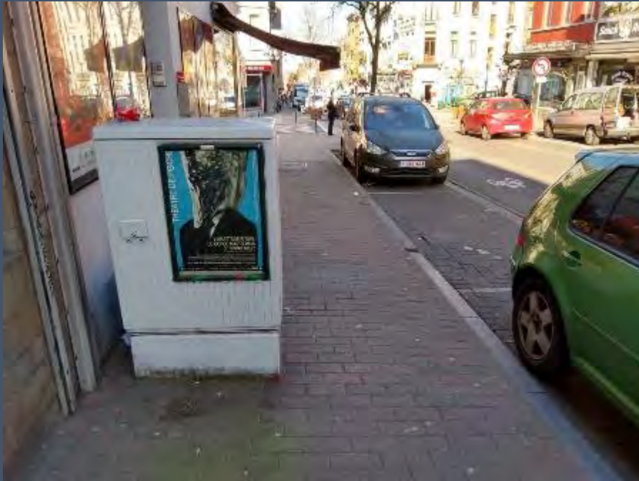
Fig.30 : Positionnement non conforme d'une armoire de concessionnaire sur la Chaussée d'Alseberg, n° 15.
