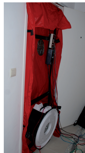
Test d'étanchéité Blower Door : ci-dessus mise en dépression et ci-dessous mise en surpression
