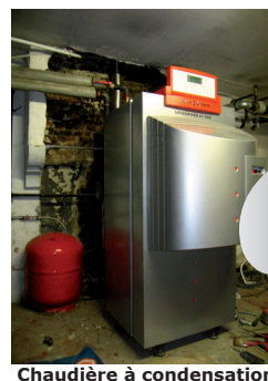
Chaudière à condensation
