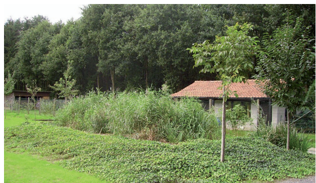
Filtre à sable planté de roseaux (2,5 m 2 /usager)
