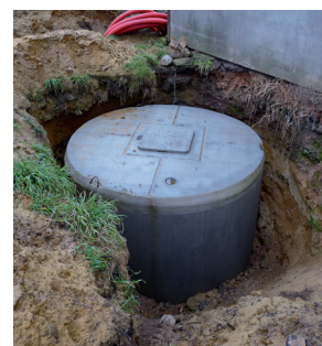
Placement d'une citerne
