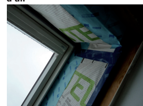
Ci-dessous, détails de châssis pour limiter les infiltrations d'air
