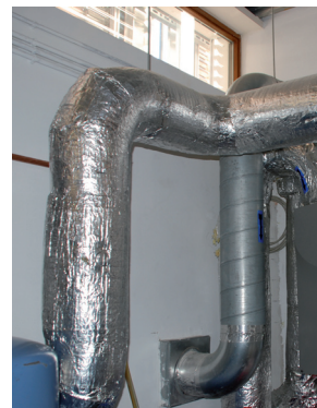
Isolation des conduits en fonction de leur contenant
