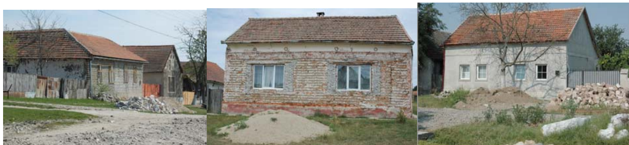
Tas de sable et de briques attestant de travaux en cours : réfection du crépi, pose de châssis en PVC (04/07)
