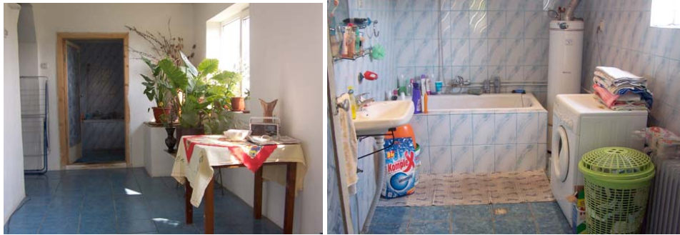
Clichés envoyés par Bianca des travaux effectués dans le coridor et la salle de bain de leur maison (04/09).
