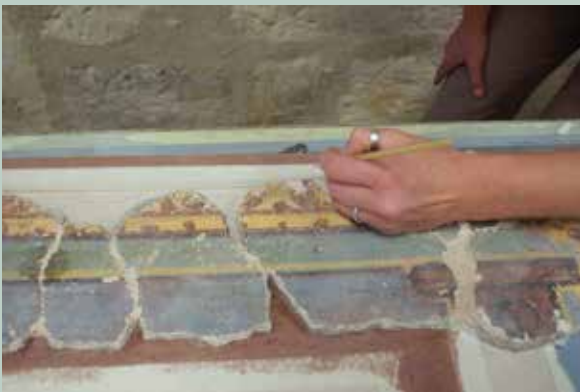
2. Restauration en cours de l'édicule à colonnes (@CEPMR).
