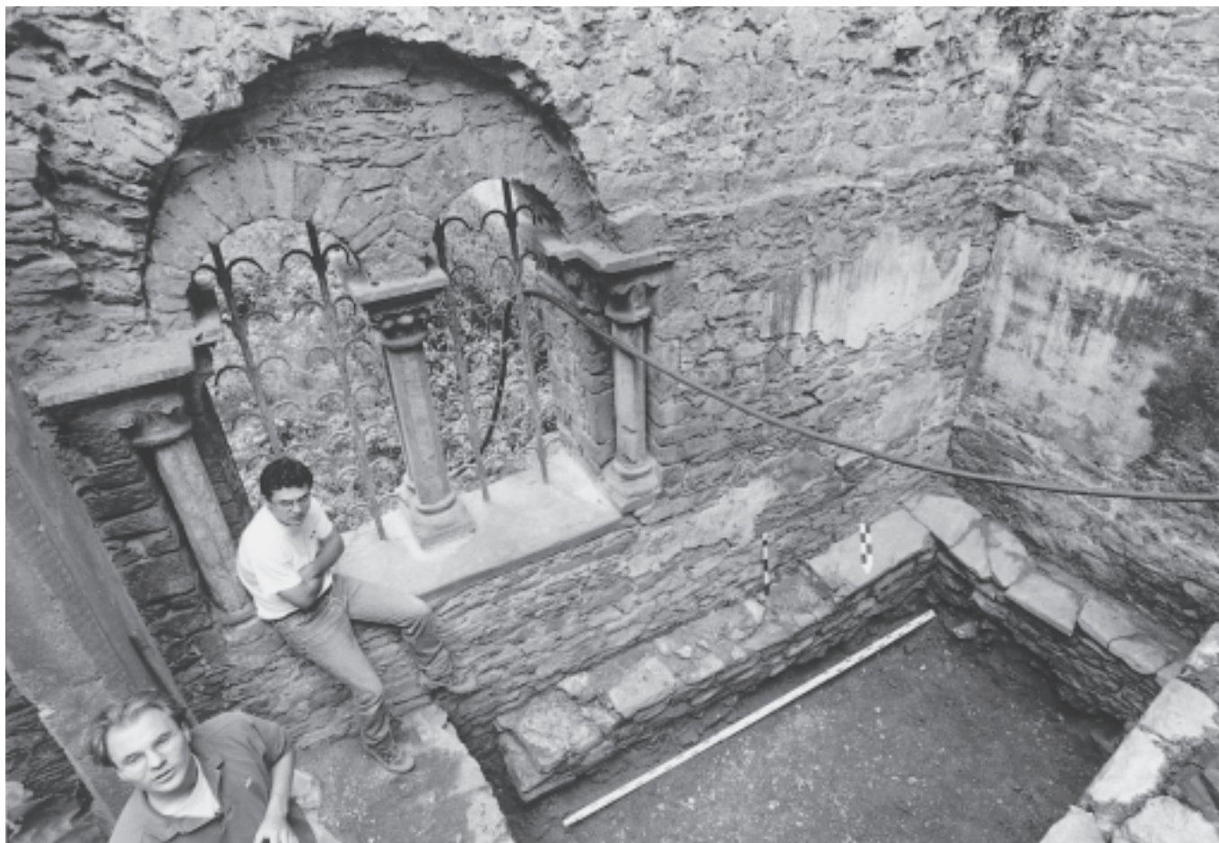
La relation des baies d'ouverture en plein cintre de la façade maintenue in situ avec les sols et les bancs maçonnés est parfaitement conservée. Ici : en cours de fouille, vue du revers de la fenêtre redécouverte en 1942, et banc périphérique de la salle appuyé au pied de la façade (à gauche) et du mur goutterot de la nef romane (à droite).
