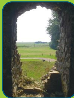
Vestige d'une baie à coussièges.
