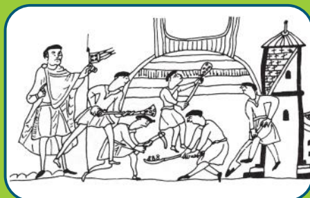
Chantier en construction d'une motte castrale d'après la tapisserie de Bayeux.
