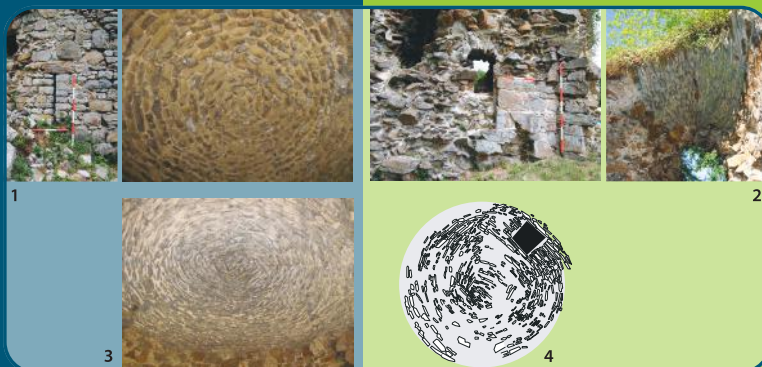
Voûtes et baies d'ouverture de la tour maîtresse (1), du châtelet d'entrée (2), et des tours d'angle ouest (3) et est (4).
