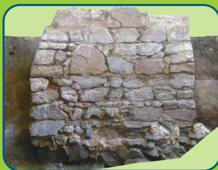
Pile de fondation du grenier médiéval de la basse-cour (13 e ou 14 e s.?).
