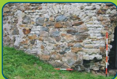
Porte du rez-de-chaussée de la tour maîtresse (début 14 e s.).
