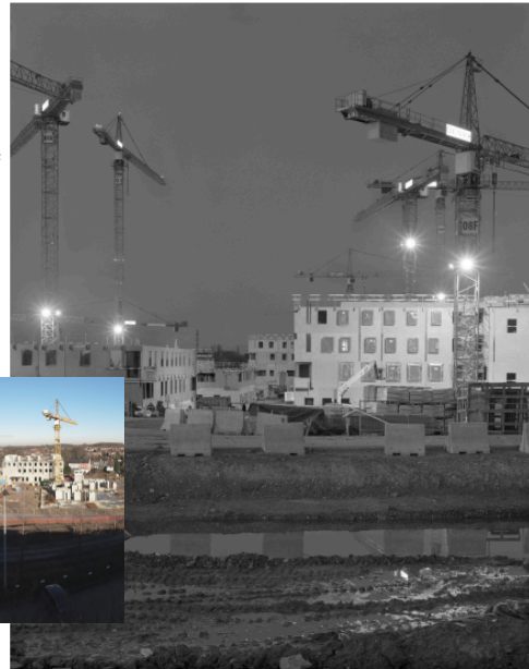
Terrain du Keelbeek, construction de la future mega prison de Haren.
