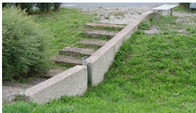
Noue en pente avec « renforcement » au point bas, au pied du barrage qui la sépare de la noue aval.
