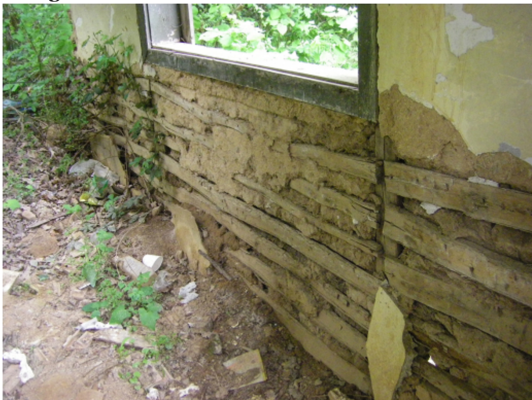
Fig. 11. Sandwich construction utilisé dans la construction d'un bâtiment du 20 e siècle à Belogradchik
