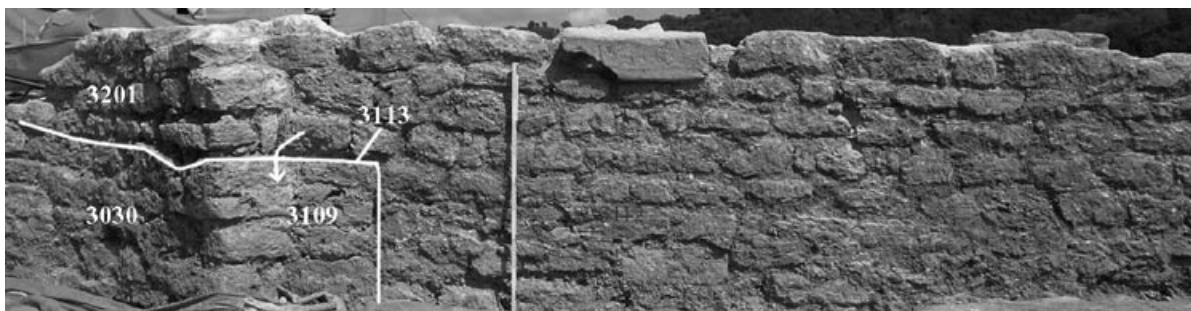
fig. 8 – ‘Vano L’: analisi della stratigrafia muraria. La parete del vano si appoggia sui resti dello spigolo, per poi proseguire in continuità andando a ricostituire lo spigolo sottostante e l’emiciclo della stessa abside di nord-est.
