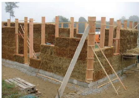
Fig. 24 : Exemple d'un chantier de Tom Rijken utilisant la technique CST.
