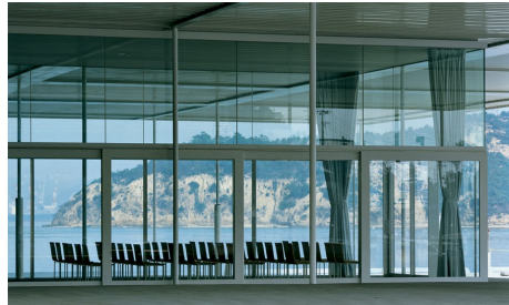
Fig.26B et 26C: SANAA, Naoshima Ferry Terminal. Vues.
