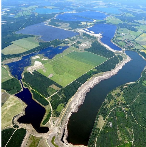
Fig.11:Lausitzer Seenland. Vue aérienne.
