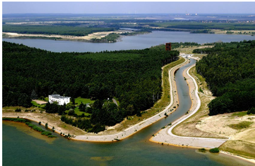
Fig.12:IBA Emscher Park. Lausitzer Seenland. Vue aérienne. Détail.
