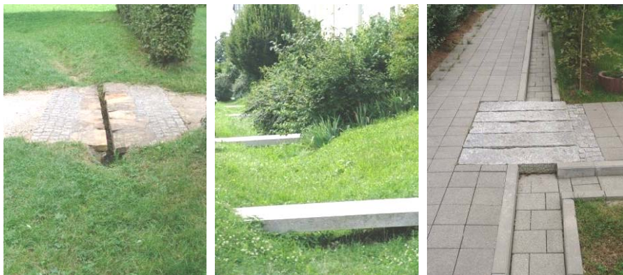
Figure 90 - Dispositifs de ralentissement, d'infiltration et d'écoulement des eaux de ruissellement des bâtiments du nord du quartier de Scharnhäuserpark.
