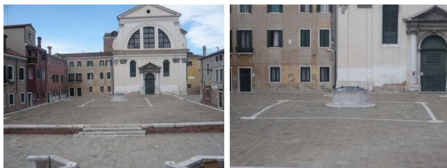
Figure 128 - Puits surélevé du campo San Troisso.
