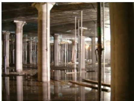
Figure 68 - Bassin d'orage sous la place Flagey, Bruxelles, mars 2006. Photo Valérie Mahaut.
