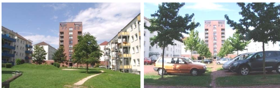
Figure 89 - Espaces entre les casernes rénovées, successivement aménagés en jardin sur lequel donnent les terrasses des logements, et en parking dont le revêtement de sol en dalle gazon et la plantation d'arbres adoucissent l'aspect minéral. Au fond de la perspective, la construction de nouveaux immeubles-tours à neuf étages ponctue et densifie ces espaces. Photos et les suivantes Valérie Mahaut.
