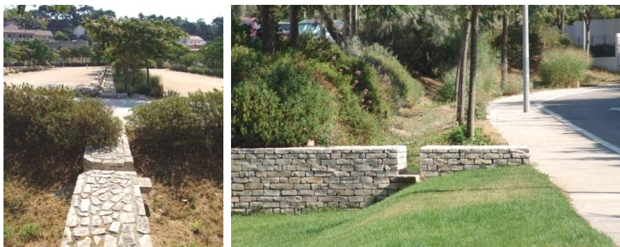
Figure 107 – Muret de barrage de la noue latérale, dans le prolongement des murets de soutènement entre deux terrasses. Ces murets sont autant de petits passages piétons informels qui donnent une certaine porosité au parking par rapport à son environnement. Le parking n'est donc pas un ghetto refermé sur lui-même dont il faut faire le tour pour passer d'une rive à l'autre du vallon. Les noues latérales peuvent être traversées et l'ensemble peut être franchi de part en part.
