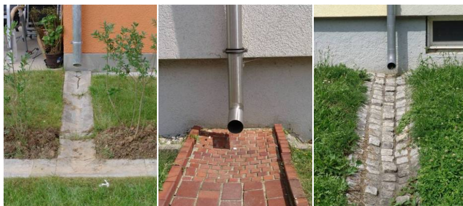
Figure 69 - Descentes d'eau dans des nouveaux quartiers allemands de Hanovre, Fribourg et Stuttgart. Photos Valérie Mahaut.
