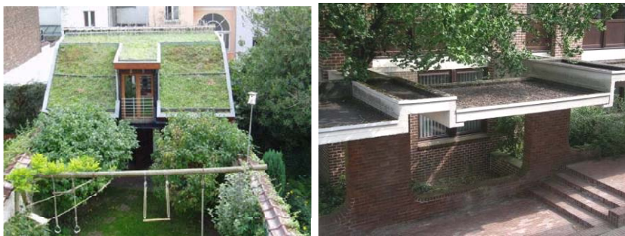
Figure 34 – Toiture verte extensive d'un bâtiment en intérieur d'îlot urbain 134 . Photo Sabine Vanderlinden. Toiture en eau permettant de retenir une partie des eaux de pluie, de les évaporer et les évacuer à débit limité. Photo Dominique Costermans.
