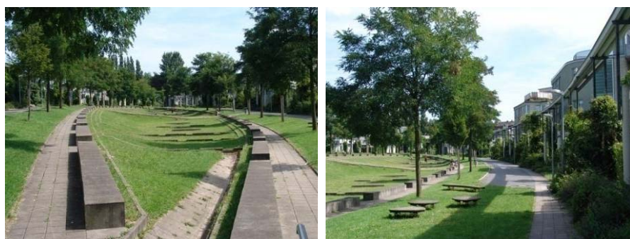
Figure 113 – Espace vert central du quartier. Sur la photo de gauche, on voit, au sol, la rigole d'amenée des eaux de ruissellement vers la cuvette de rétention et d'infiltration des eaux au centre de l'espace vert. Sur la photo de droite, les chéneaux de récolte des eaux ceinturent spatialement le jardin en forme de lentille. Toutes les photos et les suivantes Valérie Mahaut.
