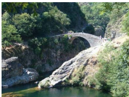
Figure 60 - Le Pont du Diable à Thueyts sur l'Ardèche. Photo Valérie Mahaut.
