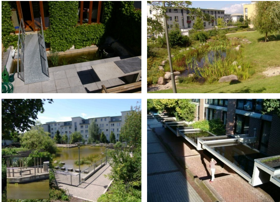
Figure 32 - Bassin en eau au pied de la façade arrière d'une maison mitoyenne bruxelloise. Photo Bernard Deprez. Bassin en eau dont le niveau de l'eau, par forte pluie, monte et déborde du bord imperméable laissant l'eau s'infiltrer dans le sol des berges engazonnées. Bassin en eau de rétention. Toiture en eau avec évacuation en différé via des petits tuyaux qui renvoient les eaux vers un terre-plein végétalisé entre le chemin couvert et le bâtiment voisin. Photos Valérie Mahaut.
