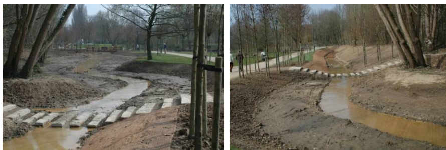
Figure 160 - Lit du Molenbeek dans le parc Roi Baudouin, phase II de la rénovation, projet de l'ATELIER 50 et de Michel DELVOSALLE. Photos Atelier 50.
