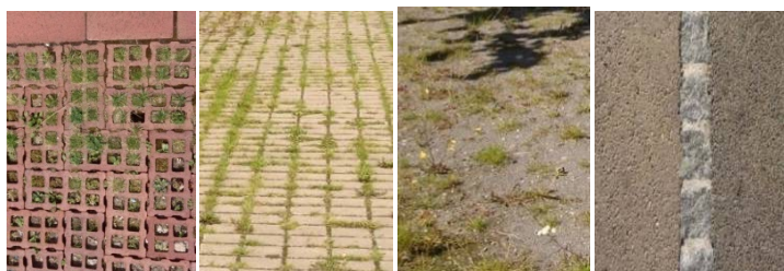
Figure 30 – Matériaux perméables à faible coefficient de ruissellement : dalle gazon, pavé à joint non cimentés, graviers, sable stabilisé, dolomie, pavés poreux, copeaux de bois, dalles gravier, revêtement drainant... Photos Valérie Mahaut.
