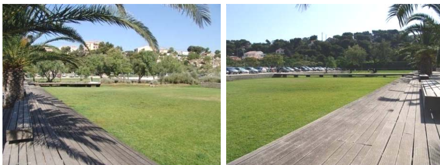
Figure 108 - Bassin d'orage engazonné permettant la rétention temporaire de 4 000 m 3 d'eau, dans la dernière terrasse de l'ensemble en aval de la succession des terrasses de parking. Deux passerelles franchissent cette dépression de sol permettant l'accès piéton par tous les temps.
