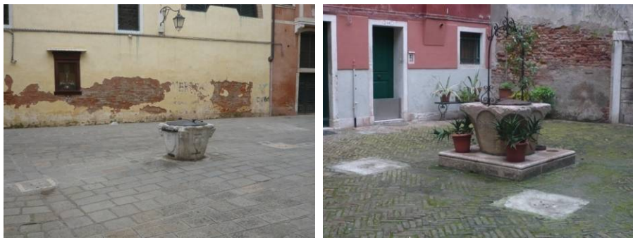
Figure 125 - Puits publics avec leurs deux gatoli d'infiltration, Calle Vincenzo Manzini.
