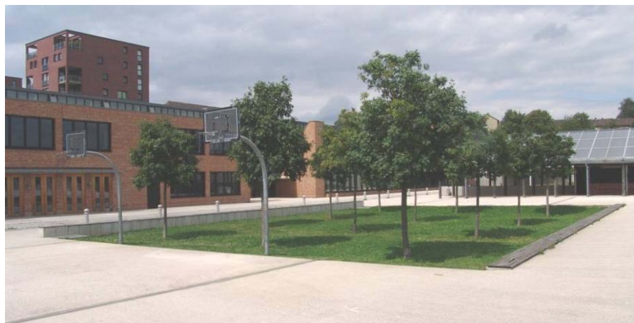
Figure 99 - Jardin d'orage au cœur des cours de récréation minérales de l'école. Le revêtement minéral est légèrement en pente vers de minces rigoles qui acheminent les eaux de ruissellement vers cet espace végétal décaissé de quelques dizaines de centimètres et planté. Ses bords ont donné l'occasion d'installer de longues banquettes revêtues de bois.
