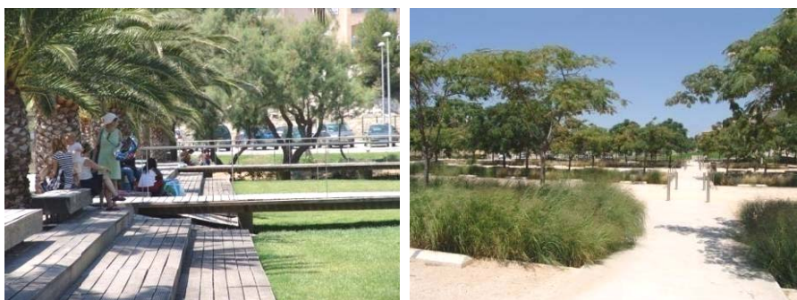
Figure 110 – Digue refermant le bassin d'orage par rapport à la plage. Des bancs et sa forme en gradins accueillent les vacanciers à l'ombre des palmiers. Parking sans voiture en début de matinée, véritable parc de promenade à la fois minéral et végétal, mettant en scène la douce pente vers la mer.
