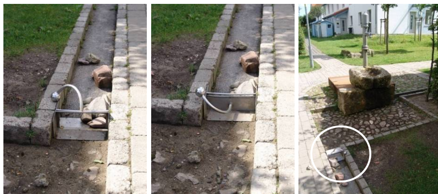
Figure 73 - Chemins de l'eau dans le quartier du Kronsberg à Hanovre, Allemagne. La poignée permet aux jeunes enfants de modifier le cours de l'eau dans la rigole. Ils peuvent participer à la maîtrise des flux et se rendre responsable de leur devenir. Photo Valérie Mahaut.
