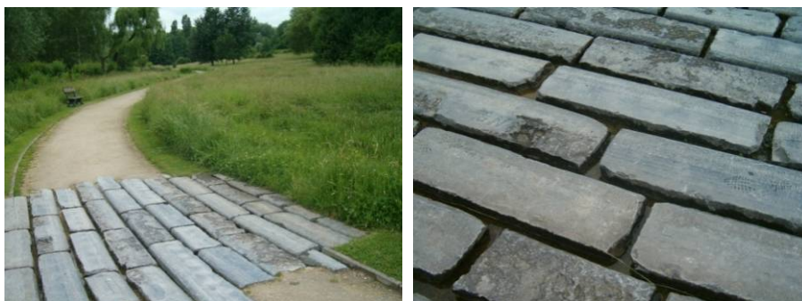
Figure 159 - Chemin longeant le Leybeek et traversé par un « chemin d'eau », trop-plein du fossé latéral recueillant les eaux de ruissellement des coteaux de la vallée. Agencement des pierres laissant filtrer l'eau vers le Leybeek et permettant le passage par temps de pluie. Photos Valérie Mahaut.
