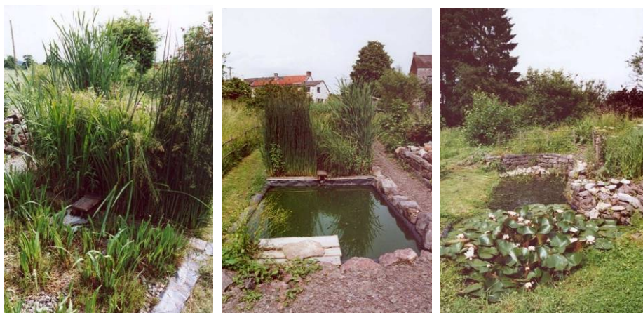
Figure 71 - Lagunage pour l'épuration des eaux domestiques de la famille Heyden à Rochefort. Acte 1 : première lagune en gravier. Acte 2 : lagune en eau à microphytes. Acte 3 : roselière plantée avec surverse dans un bassin d'agrément. Photos Valérie Mahaut.
