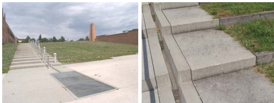
Figure 98 - Escalier d'accès aux cours de récréation de l'école gardienne et primaire. A gauche de l'escalier, les bâtiments de l'école. A droite de l'escalier, la salle de sport et les deux cheminées. Photo de droite : détail de l'escalier montrant les marches minérales et végétales, ainsi que la rigole de récupération des eaux de ruissellement, elle-même en escalier pour ralentir les eaux.
