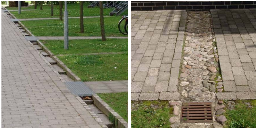
Figure 33 - Rigoles, canaux... qui ralentissent les eaux par une rugosité plus importante, par un rallongement du chemin emprunté par l'eau ou par réduction des pentes et de la vitesse de l'eau. Photos Valérie Mahaut.
