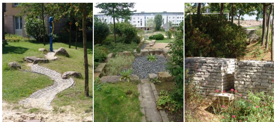
Figure 69 - Descentes d'eau dans des nouveaux quartiers allemands de Hanovre, Fribourg et Stuttgart. Photos Valérie Mahaut.
