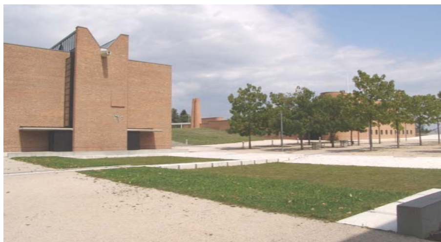
Figure 97 - Façade de l'école gardienne et primaire avec la gargouille de rejet des eaux de la couverture des lanterneaux vers le jardin d'orage en face de celui-ci. A droite, l'escalier verdurisé marque l'entrée des cours de récréation. Au fond, les cheminées jumelées du complexe.
