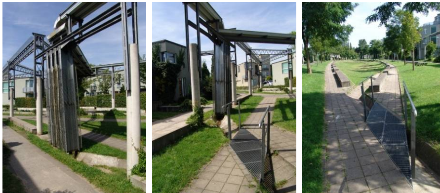
Figure 118 – Système de descente des eaux pluviales du quartier depuis les écoulements perchés à quatre mètres de hauteur vers la rigole creusée dans le sol et qui conduit vers le jardin d'orage.
