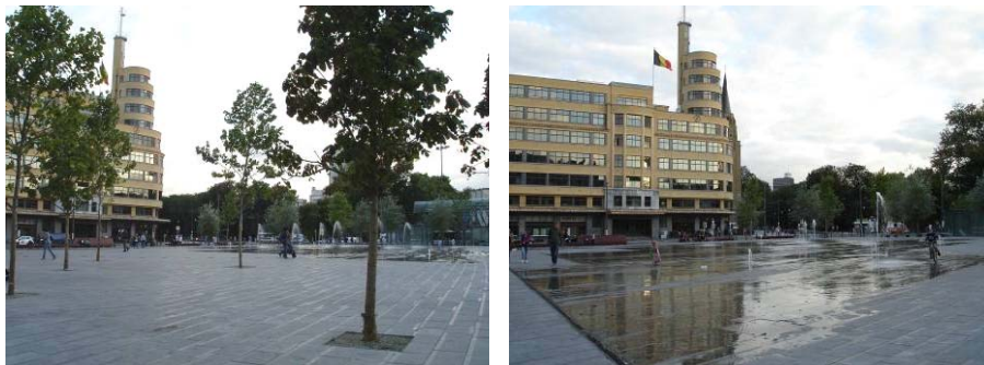
Figure 163 – La place Flagey à Ixelles est réalisée à l'emplacement d'un ancien étang de la vallée du Maelbeek. Le revêtement de sol dissimule un bassin d'orage de 30 000 m 3 . Les joints du calpinage des pierres sont volontairement disposés dans le sens d'écoulement des eaux de la vallée. Photos Valérie Mahaut.
