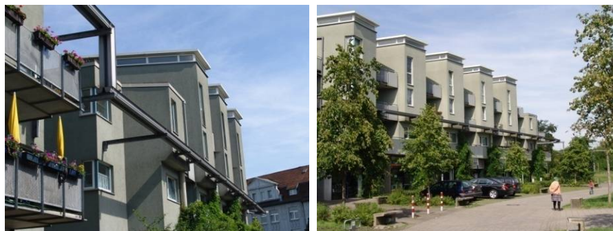
Figure 116 - Collecte des eaux de ruissellement des toitures grâce à un système de descente d'eau et de chéneaux, parfois peu élégant et qui semble, malheureusement trop souvent, rapporté aux façades et peu intégré aux constructions.
