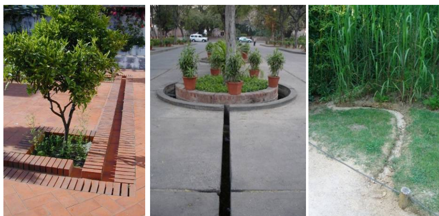
Figure 72 - Rigole dirigeant les eaux de pluie vers le pied d'un arbre dans une cour de Barcelone, Espagne. Rigole de récolte des eaux de mousson sous une rue d'accès vers le massif planté poreux de l'Indian Institute of Management Ahmedabad, Gujarat, Inde (Architecte : Louis Kahn). Rigole d'évacuation des eaux de ruissellement d'un chemin vers les végétations, jardins de Chaumont-sur-Loire, France. Photo Valérie Mahaut.
