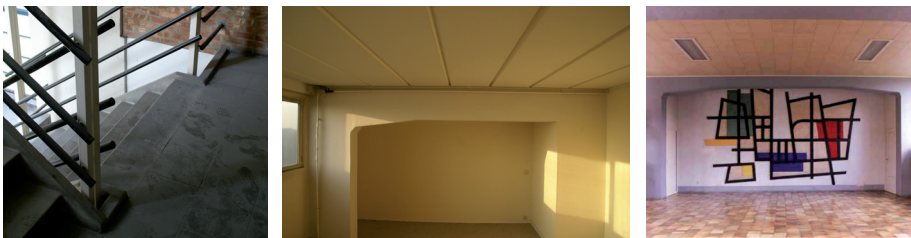
Garde-corps des escaliers collectifs ; Hourdis apparents des plafonds ; Fresque murale de Jo Delahaut
