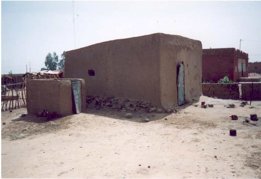
Photo n° 1 : Forme de mise en valeur de la parcelle : construction d'un bâtiment en banco (source : Sall, 2002)
