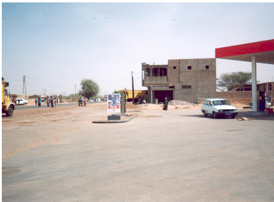
Photo n° 8 : Construction pour un usage mixte : le rez-de-chaussée abrite les magasins et le premier niveau, le logement familial (source : Sall, 2002).
