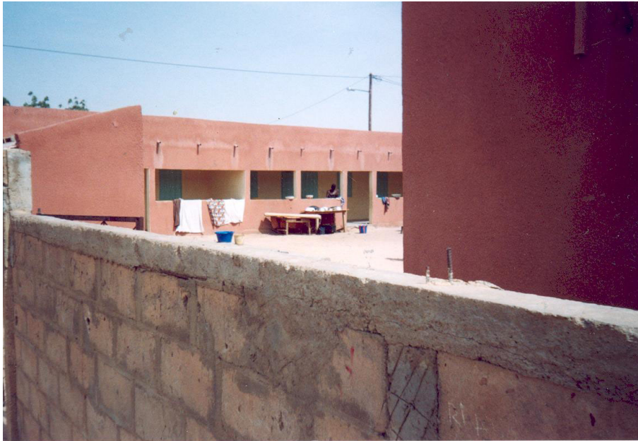
Photo n° 12 : Construction d'appartements individualisés : l'usage locatif se lit dans le style architectural (source : Sall, 2002)
