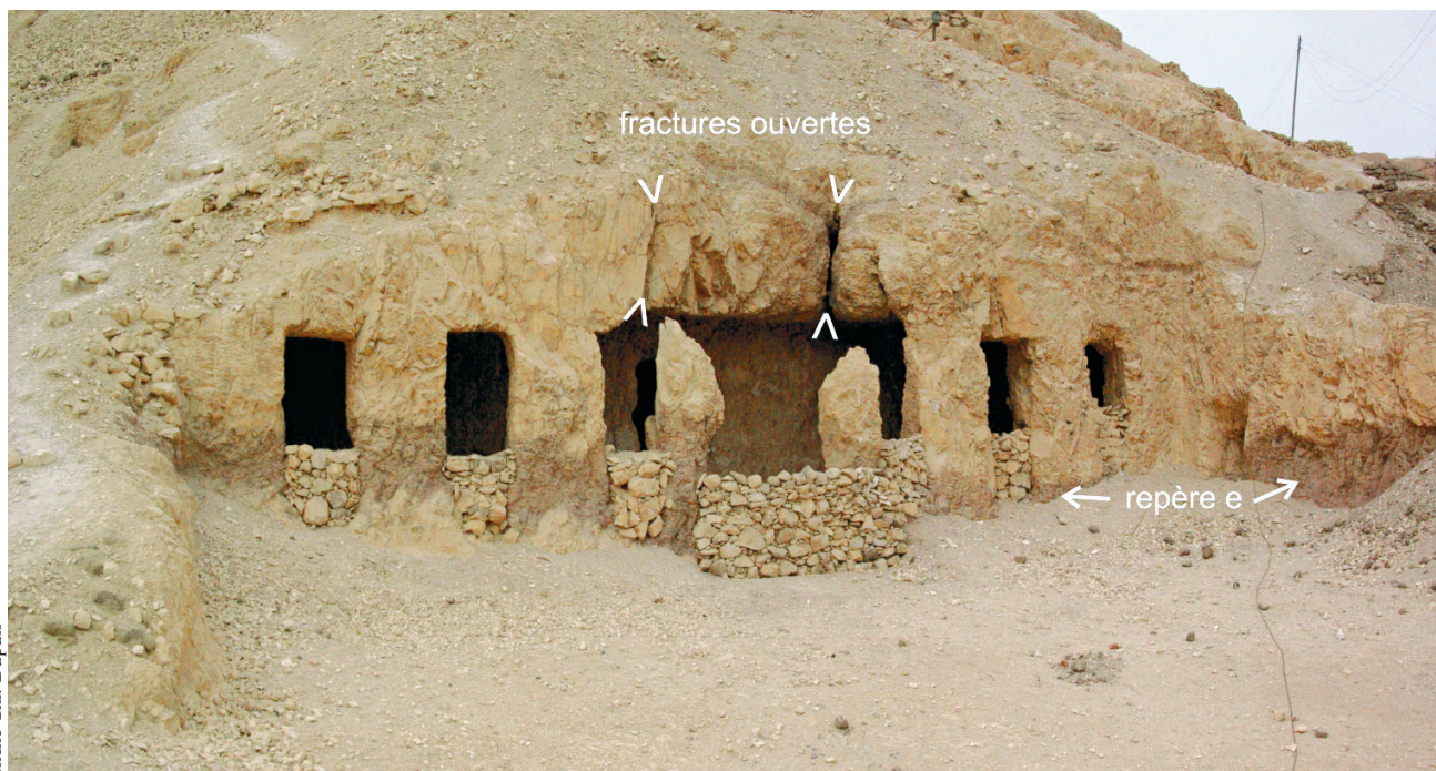
FIG. 19. Façade de la TT 67 en partie creusée dans la marne e (partie inférieure des piliers), en partie dans le banc calcaire du sommet de l'unité 2 (partie supérieure des piliers). Dégâts liés aux fractures ouvertes.
