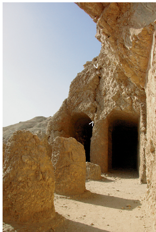
FIG. 14. Effondrement de la salle transversale de la TT 71 en relation probable avec la fracture ouverte (flèches).
