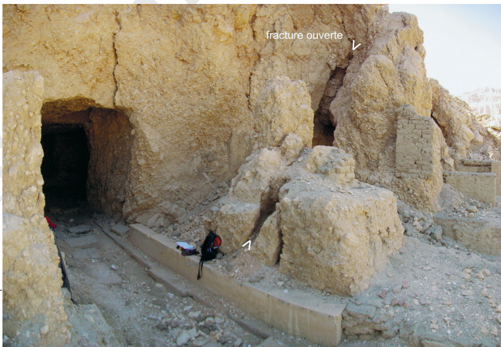
FIG. 18. Entrée de la salle longue de la tombe de Dagi (TT 103/MMA 807) avec assises des murs axiaux construits en calcaire fin sur un soubassement de grès. Fracture ouverte (flèches) en partie responsable de l'effondrement de la salle transversale.
