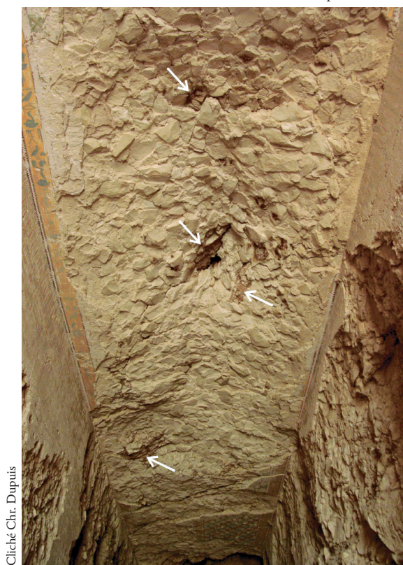
FIG. 13. Poche karstique perçant le plafond de la salle longue de la TT 71 (flèches) et réparation effectuée avec des éclats de calcaire maçonnés au plâtre.
