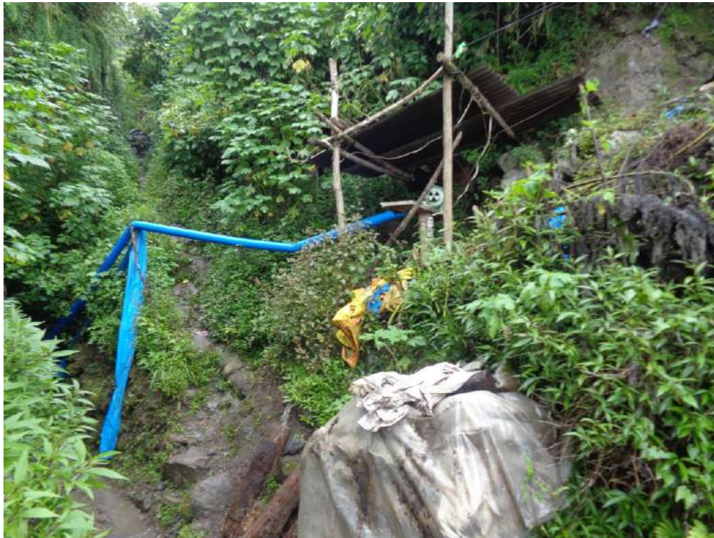
Figure 67. Tunnel avec un conduit d'air en plastic alimenté par un générateur à carburant. Kalabkaben, mars 2020.
