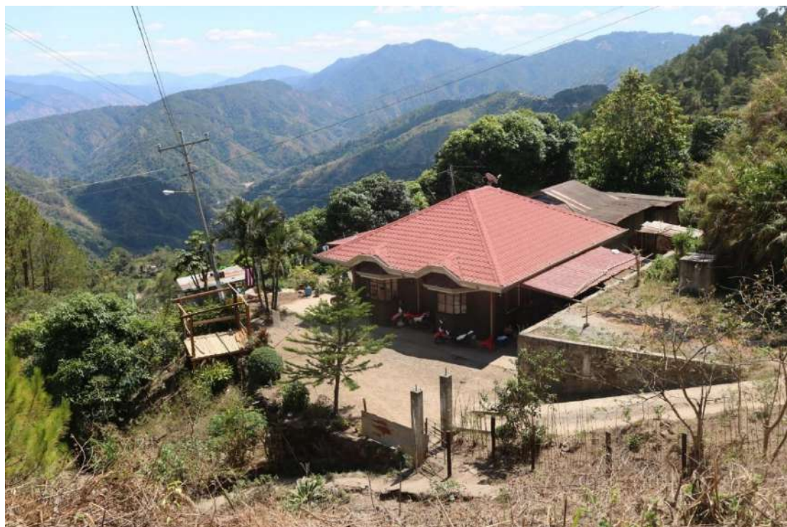
Figure 87. Maison ibaloy faite de béton, de briques, et de tuiles. Acnip, mars 2020.
