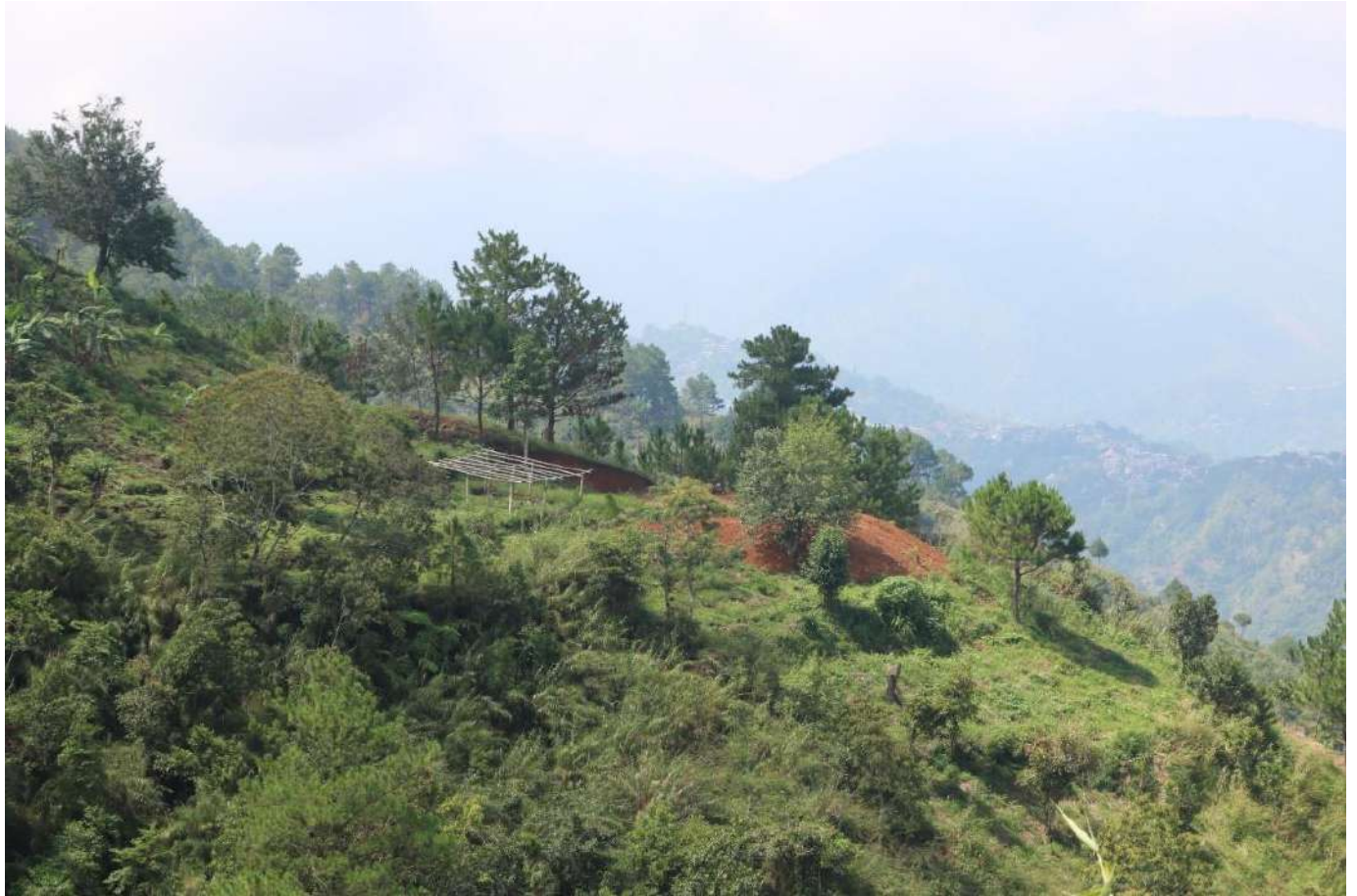
Figure 27. Poulailler en construction. Tekkong, mars 2020.
