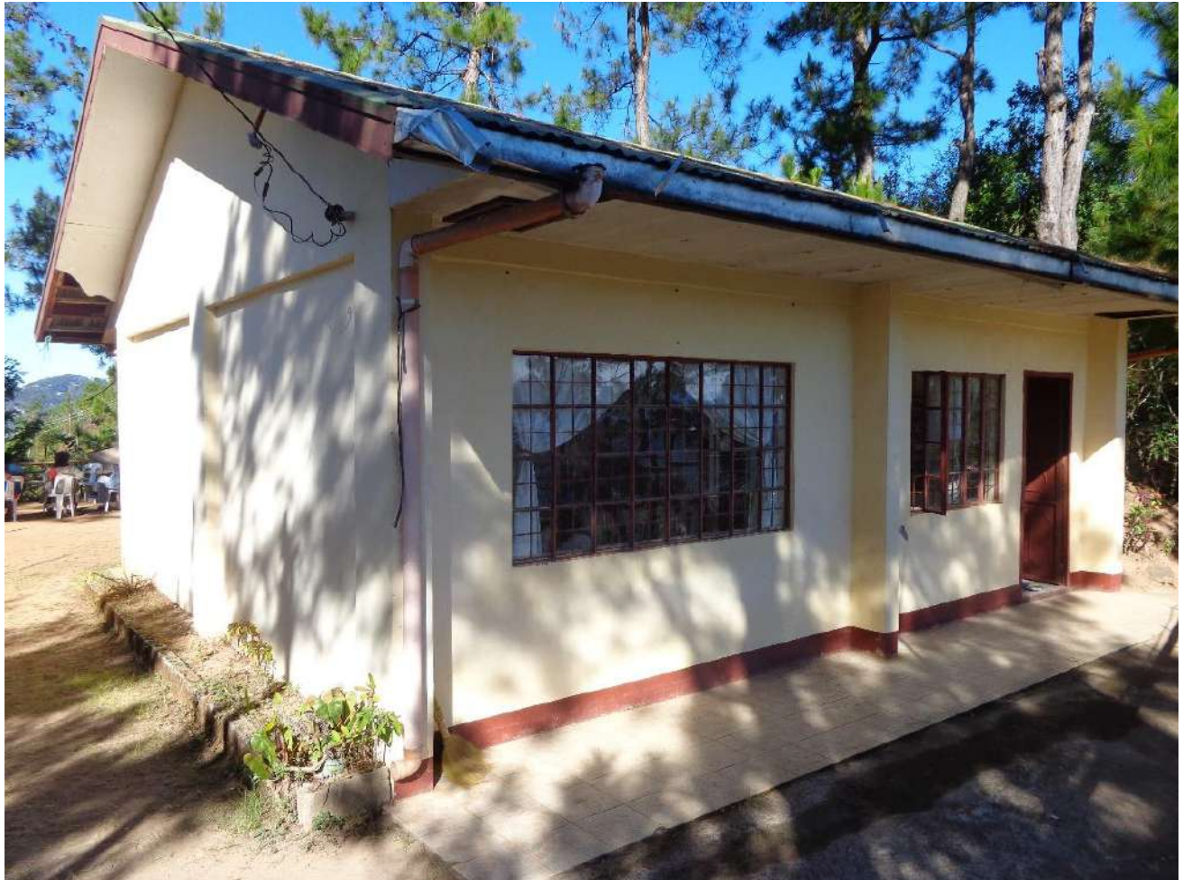
Figure 17. La maison des aînés. Sabkil, février 2018.
