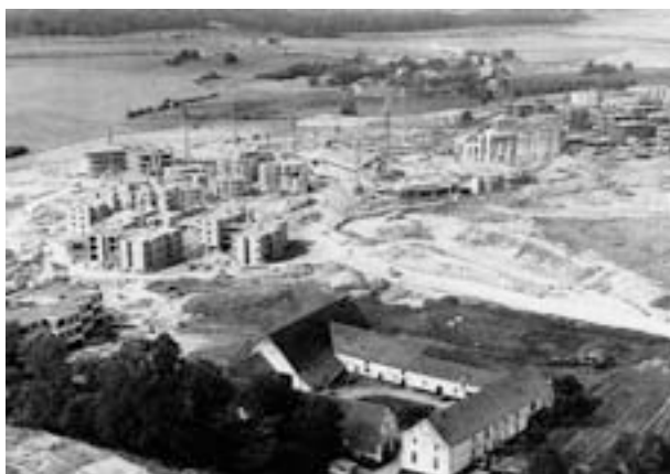
Les débuts de Louvain-la-Neuve : le quartier des sciences. La première construction de Louvain-la-Neuve fut le cyclotron, commencé dès 1969. On reconnaît ici, derrière la ferme du Bièreau, le premier ensemble de constructions de la ville proprement dite : à gauche, les bâtiments des sciences groupés autour de la « place Sainte-Barbe » et précédés de la bibliothèque des sciences et de la « place Galilée » en construction ; à droite, le premier îlot d'habitations, avec, à l'avant, la future « place des Paniers », et à l'arrière, les « rue » et « place des Wallons ». Photo CHUL.
