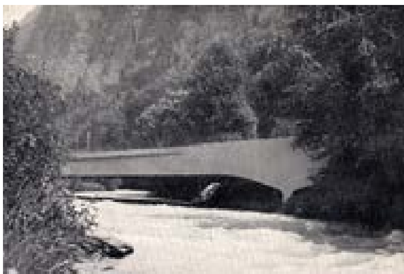
Fig. 5.18 : pont sur la Lütschinen à Grindelwald, Maillart, 1937 – source : Bill [1955], p. 108
