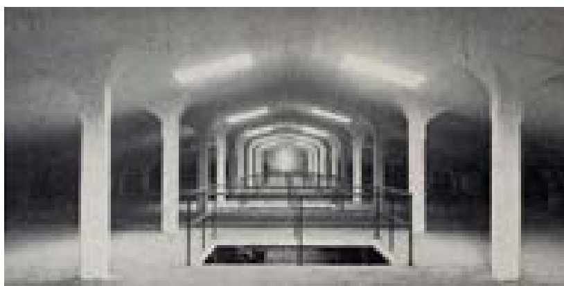
Fig. 8.4 : couverture du dépôt des Magazzini Generali de Chiasso, 1924, Robert Maillart ingénieur, in Bill [1955], fig. 244
