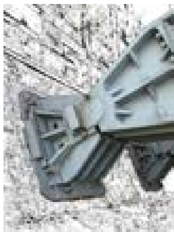
Fig. 6.3 : articulations au pied des arcs du pont de Fragnée (1901-04), et Articulation métallique pour arc en béton – Sources : < www.structurae.de > et Billington [1979], p. 11, annotés
