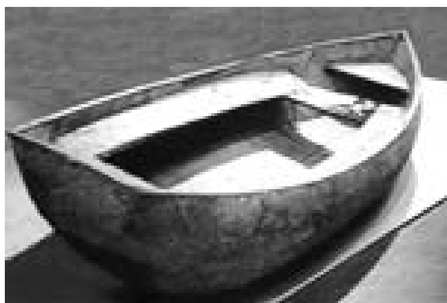
Fig. 5.3 : la barque en ciment armé de Joseph Louis Lambot en 1848 – source : < http://www.tecnologos.it/Articoli/articoli/numero_010/concrete.asp > [en ligne]
