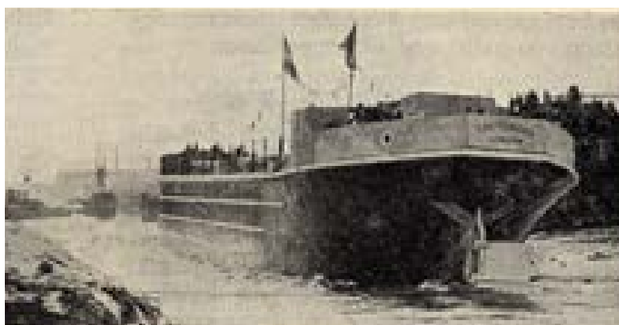
Fig. 5.5 : lancement d'un bateau en béton de 1000 tonnes à Gloucester vers 1930 – source : Gerard [1930] , p. 11
