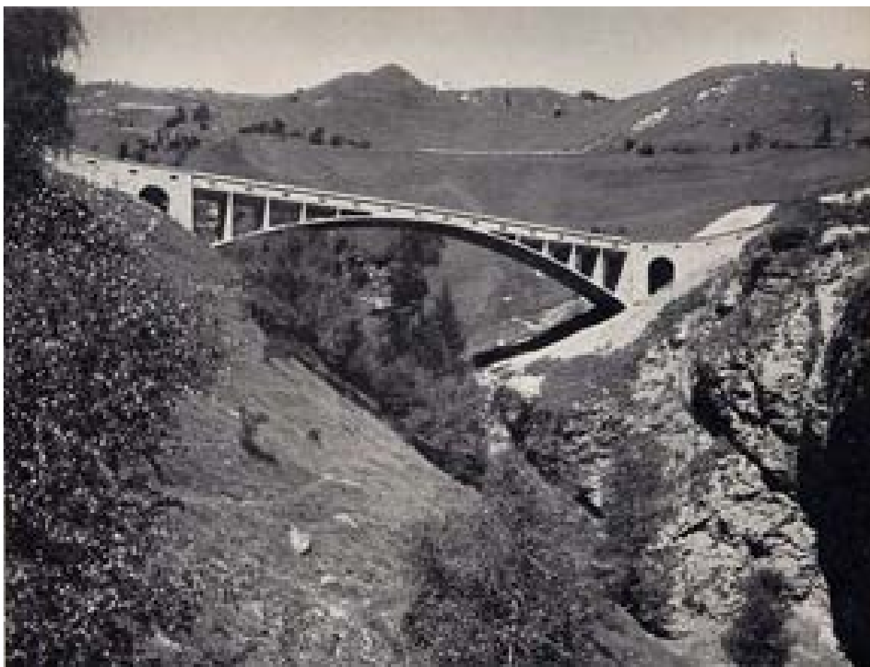
Fig. 7.9 : pont sur le Val Tschiel (Valtschielbach) à Donath, Robert Maillart ingénieur, 1925 – source : Bill [1955], p. 57
