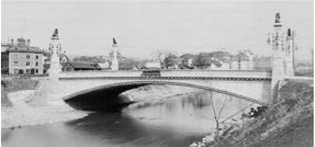
Fig. 6.4 : pont Stauffacher à Zurich, Robert Maillart, 1899 – Source : Billington [1997a] , p. 13
