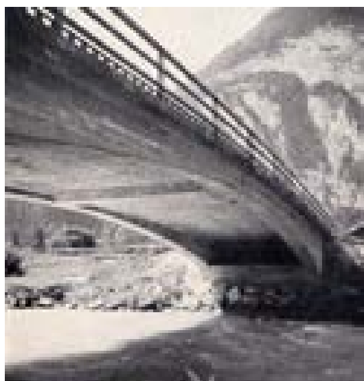
Fig. 5.13: dessous du pont à Innertkirchen, R. Maillart, 1934 – source : Bill [1955], p. 103
