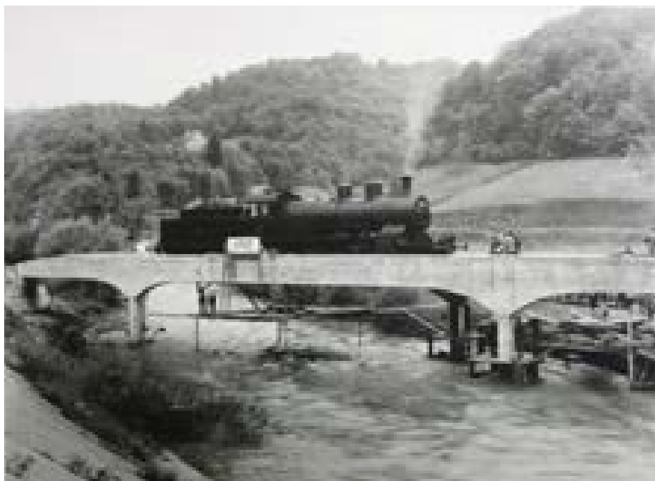
Fig.3.3 : essai de mise en charge du pont sur la Birs à Liesberg, Robert Maillart ingénieur, 1935 – source : cliché de l'auteur de la photo au dossier HS 1085 RM 1935-1 des Archives Maillart à l'ETHZ.
