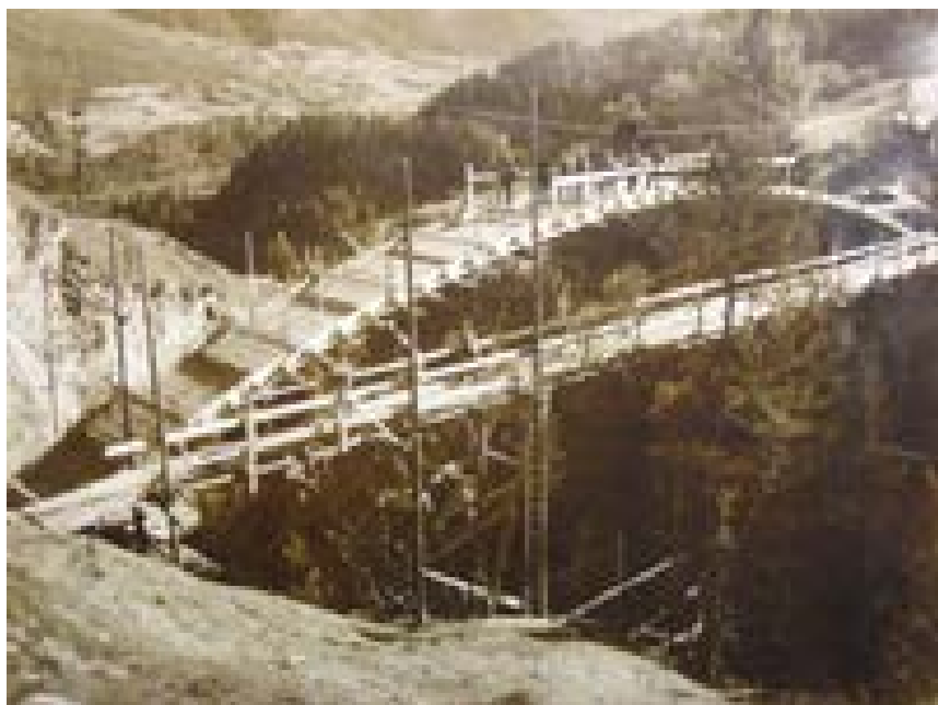
Fig. 7.15 : photographie du coffrage et du ferrillage de l'arc du pont sur le Val Tschiel à Donath. Robert Maillart ingénieur, 1925 – source : dossier HS 2085 RM 1926-1 des archives ETHZ
