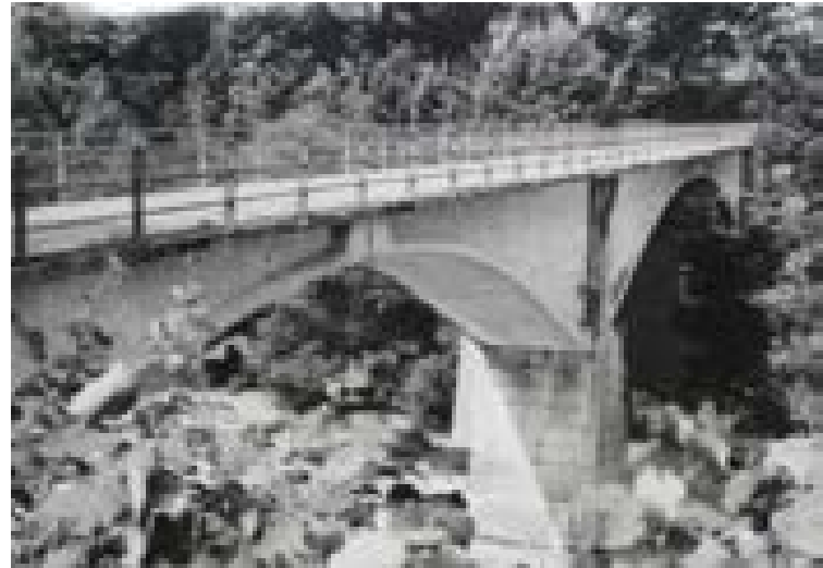
Fig. 6.7 : pont sur la Thur à Billwil, R. Maillart, 1904, – cliché de l'auteur d'après le dossier HS1085 RM1903-02 des Archives ETHZ
