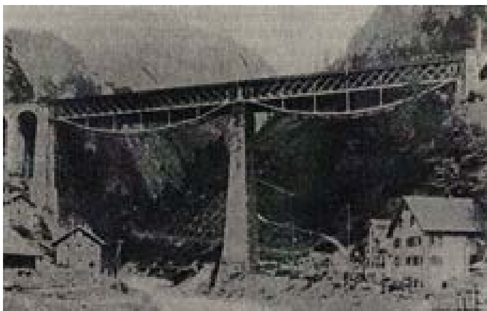
Fig. 8.63 : pont du Karstelenbach à Armsteg, treillis de 1881 sous-tendu en 1908. Carte postale de Robert Maillart – Source : Billington [1979], FIG. 7-4 p. 65
