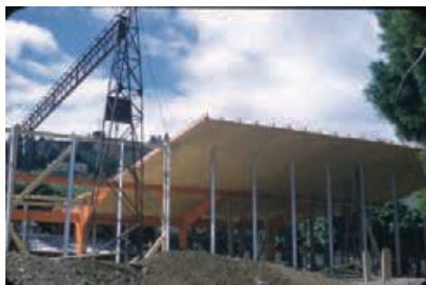
Fig. 4 – il cantiere nell'agosto 1956: montaggio del complesso di copertura (Centre Pompidou, Bibliothèque Kandinsky, fondo Jean Prouvé, Parigi, CCI © Prolitteris).
