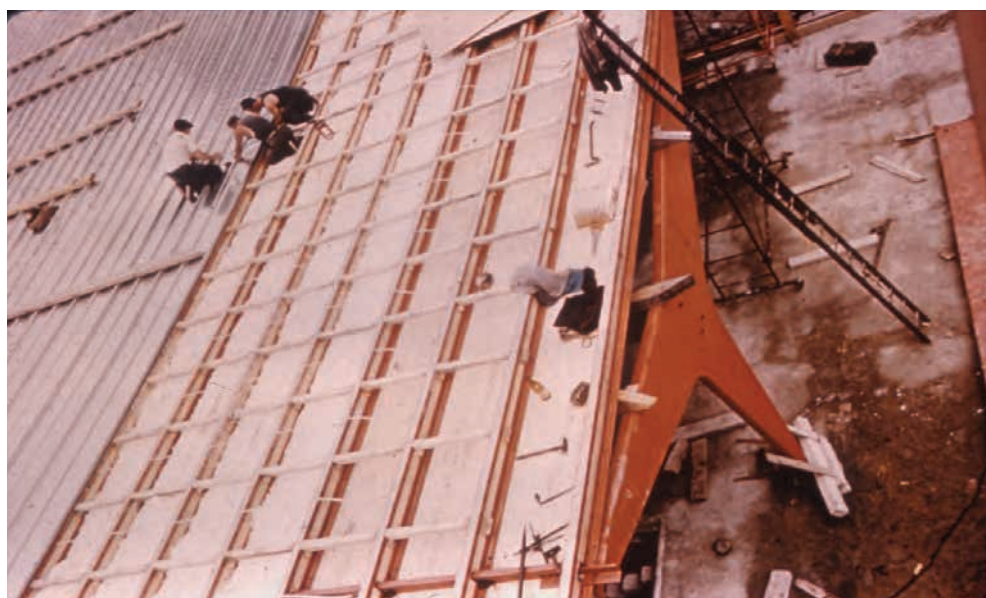
Fig. 5 – Il cantiere della buvette, sequenza del montaggio della copertura. Da destra a sinistra: i pannelli Rousseau, le nervature in legno e acciaio, i distanzatori, l'isolante e i pannelli prefabbricati di copertura Triondal in alluminio (CCI © Prolitteris).
