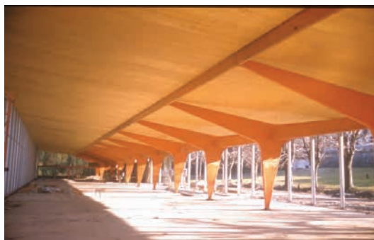
Fig. 3 – A sinistra, lo schema costruttivo (archivio S. Ketoff, Parigi © Prolitteris); a destra, una immagine del cantiere: la successione delle béquilles, opportunamente controventate, sostiene la copertura in legno e acciaio a doppia curvatura (ADHS, © Prolitteris).
