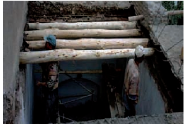
Substitution des poutres détériorées par des poutres neuves de cyprès
