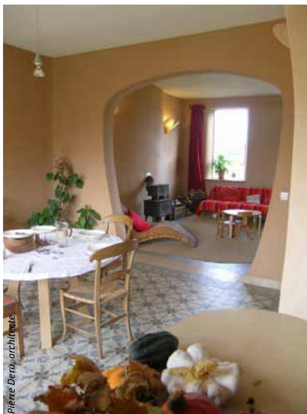
Enduit à l'argile.
