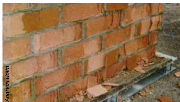
Exemple de briques gélives soumises au gel.
