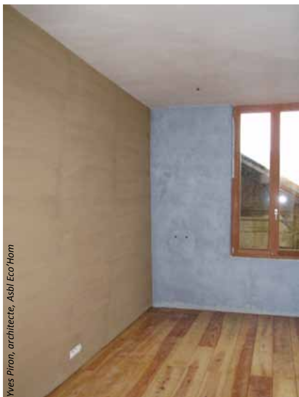
Enduit chaux-chanvre au fond et enduit à l'argile à gauche.
