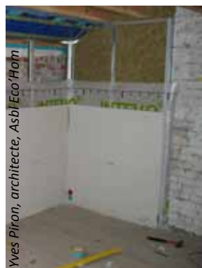
Retour d'isolant sur le mur de refend.
