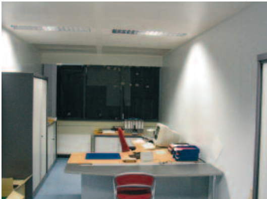
Figure 33 : Occultation des baies au moyen de bâches
