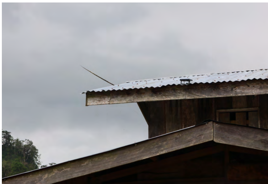
Fig. 10 - Pieu aiguisé sur un toit de maison en guise de défense. Photo : Antoine Laugrand, 2018.
