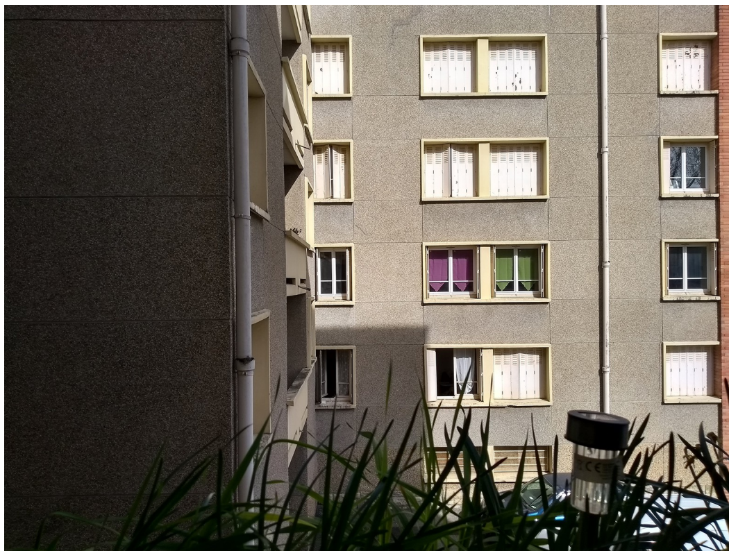
Figure 18 : Jumelage des baies à la Belle Paule
