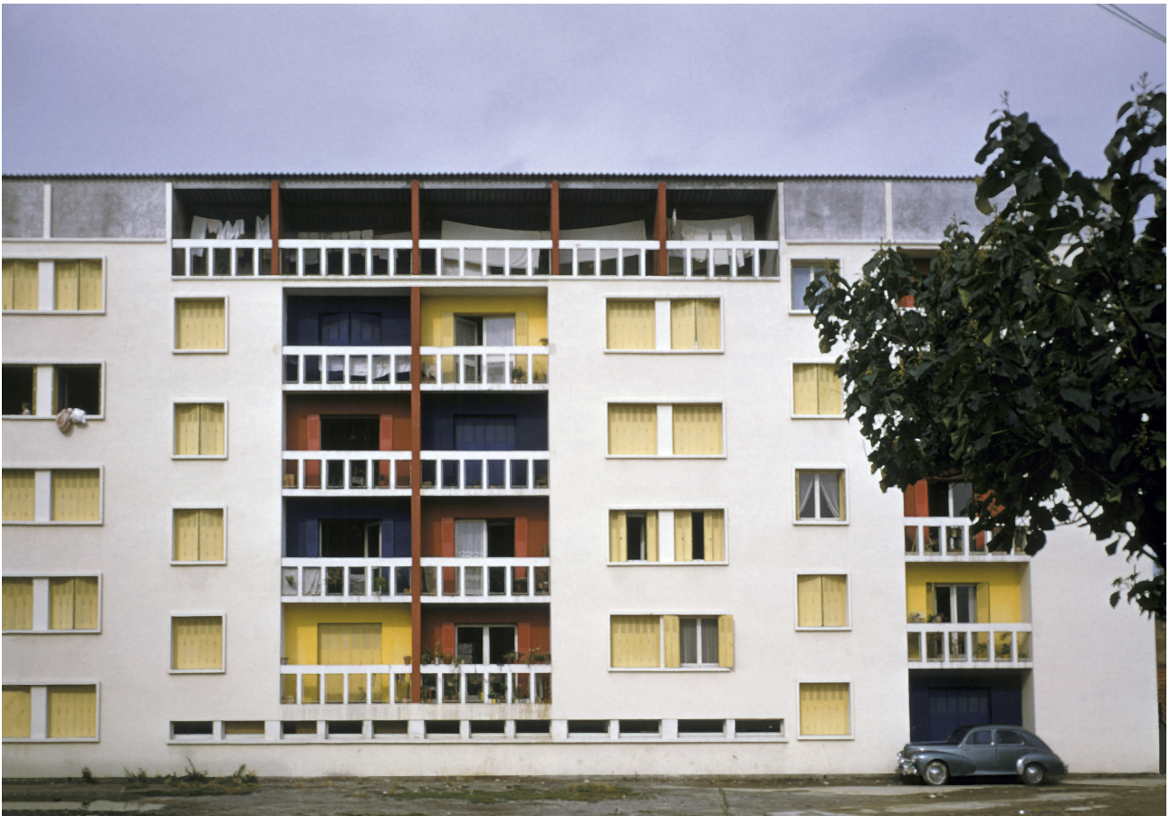
Figure 11 : Toit terrasse accessible des immeubles de la cité Roguet, 1953 - Tout droits réservés TERRA – STU01446
