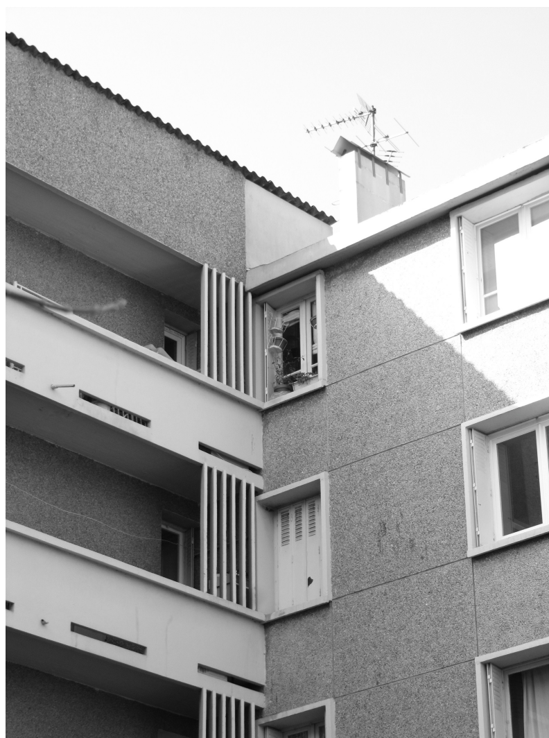
Figure 21 : Enduit de mignonnette découpé au faux panneaux
