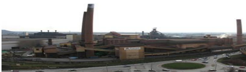
Sitio industrial de CARSID, a Charleroi
