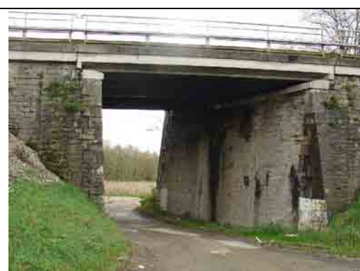
Pont permettant de traverser une ligne de chemin de fer
