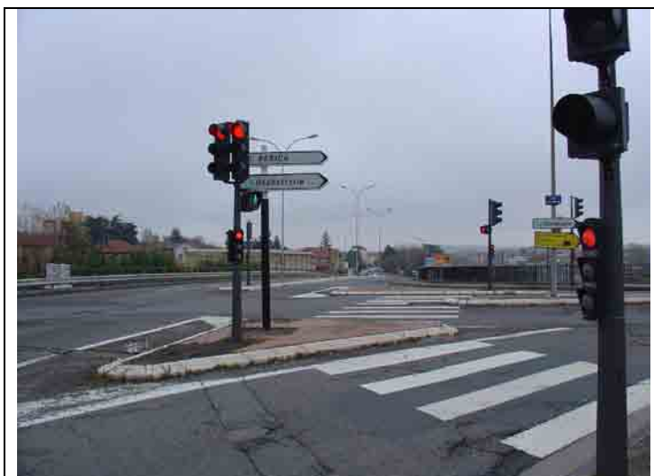
Exemple de croisement au même niveau : carrefour à Sathonay
