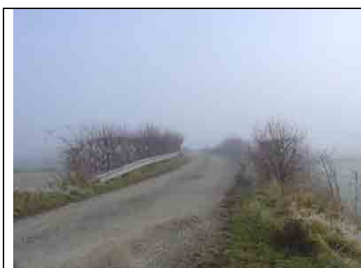
Pont permettant de traverser l'autoroute A46
