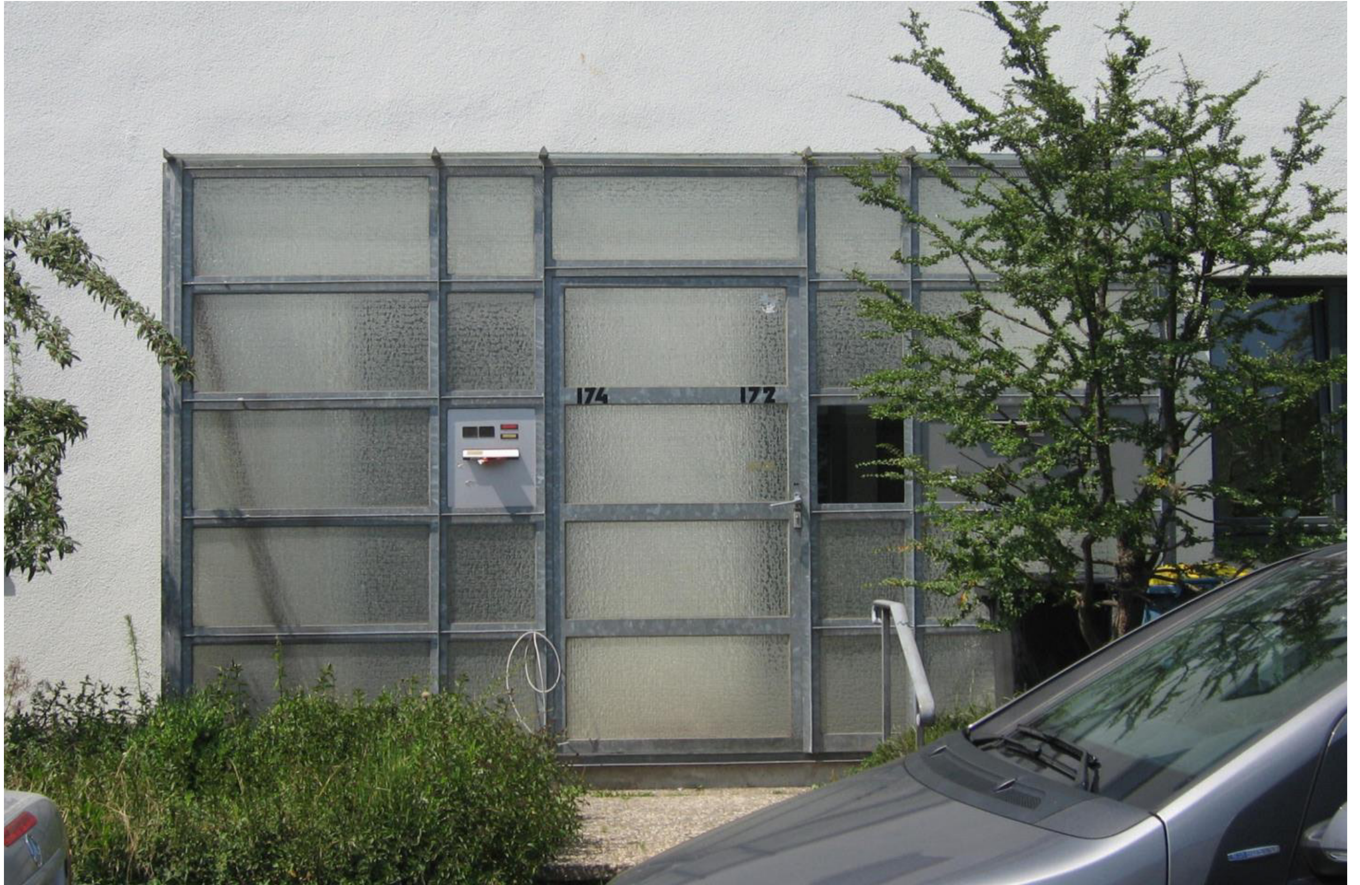
MAY, Siedlung Praunheim , 1928
