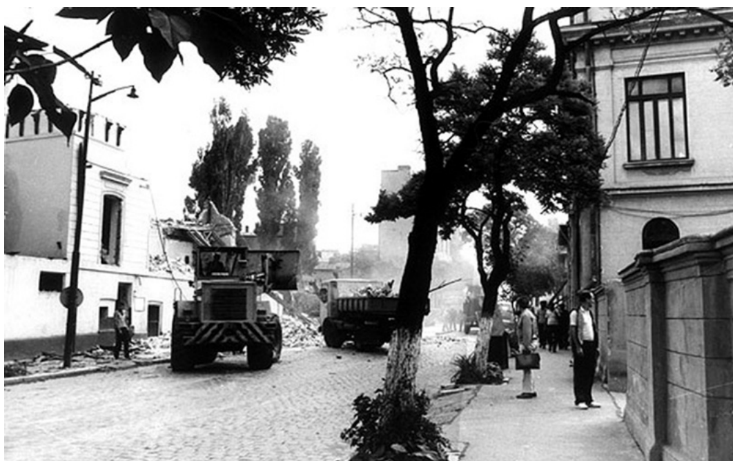
Démolitions dans le quartier de Rahova-Uranus au milieu des années 1980 pour la construction de la Maison du Peuple. © Musée Municipal de Bucarest.
