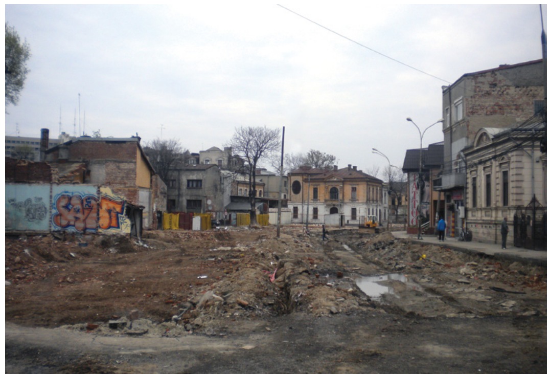
Les démolitions dans le quartier de Buzești-Berzei pour la construction de la Diamétrale Nord-Sud, avril 2011. © C. Salembier.
