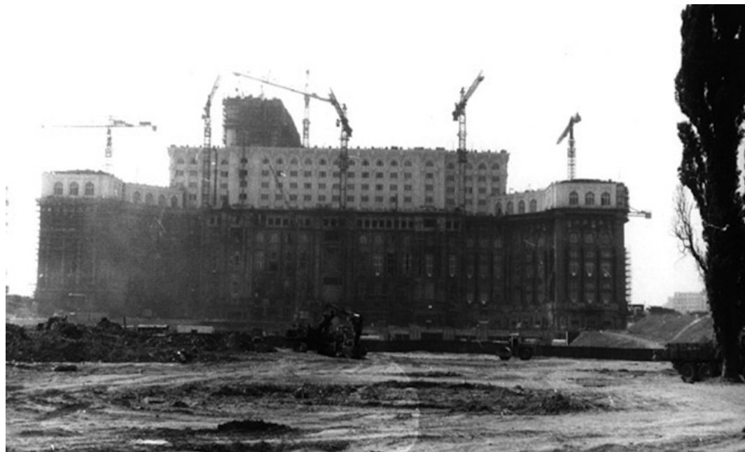
La Maison du Peuple en travaux durant la décennie 1980. © Musée Municipal de Bucarest.
