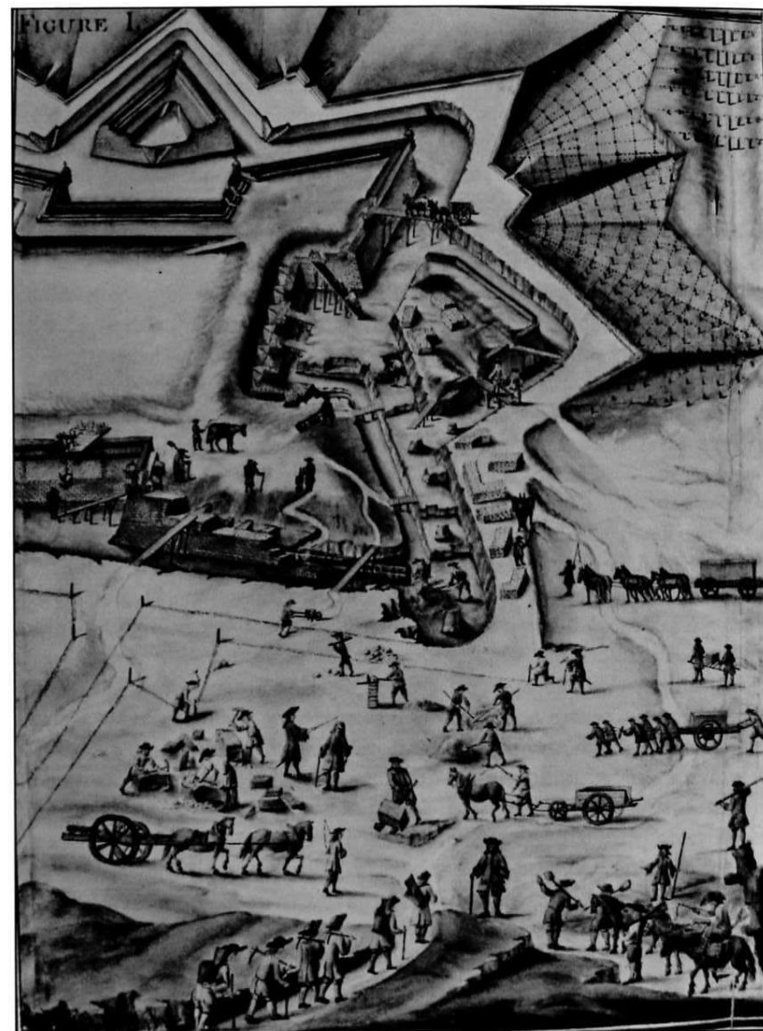
Abb 02: La construction d'une fortification, planche de l'Atlas de Masse, « Traité de Fortification »; Bibl. Inspect. Génie, Paris; reproduction: Musée Municipale de Sarlouis.
