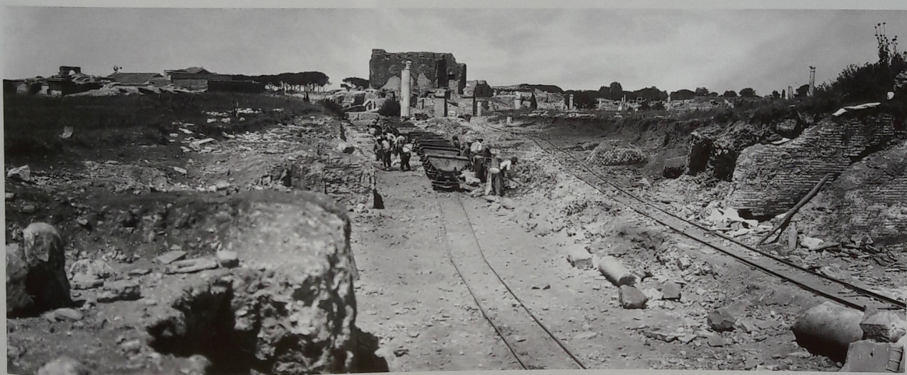
SCAVI E STERRI. Ostia Antica in corso di scavo nel 1938. Sullo sfondo si può ammirare la mole del Capitolium. La città fu in gran parte messa in luce con sterri affrettati in vista dell'Esposizione Universale che si sarebbe dovuta tenere a Roma nel 1942.
