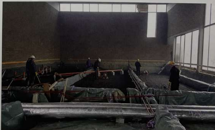
De Sint-Jozef Arbeiderkerk tijdens de werken: op de foto zijn de leidingen voor het ventilatiesysteem en de isolatie met kleikorrels goed zichtbaar (foto Monument Goedleven)
