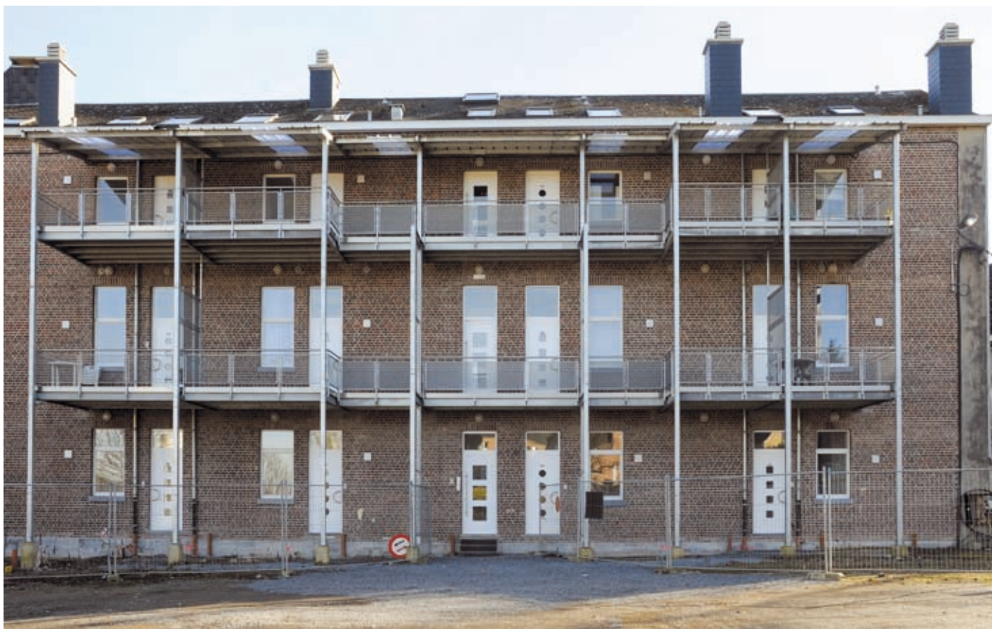
Ancien couvent de Befve, façade arrière, photo : F. Dor © MRW
