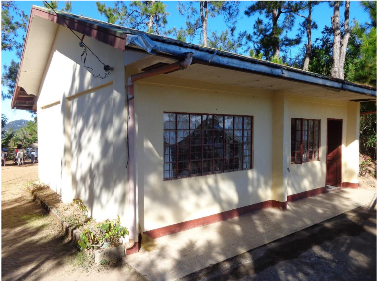
Figure 17. La maison des aînés. Sabkil, février 2018.
