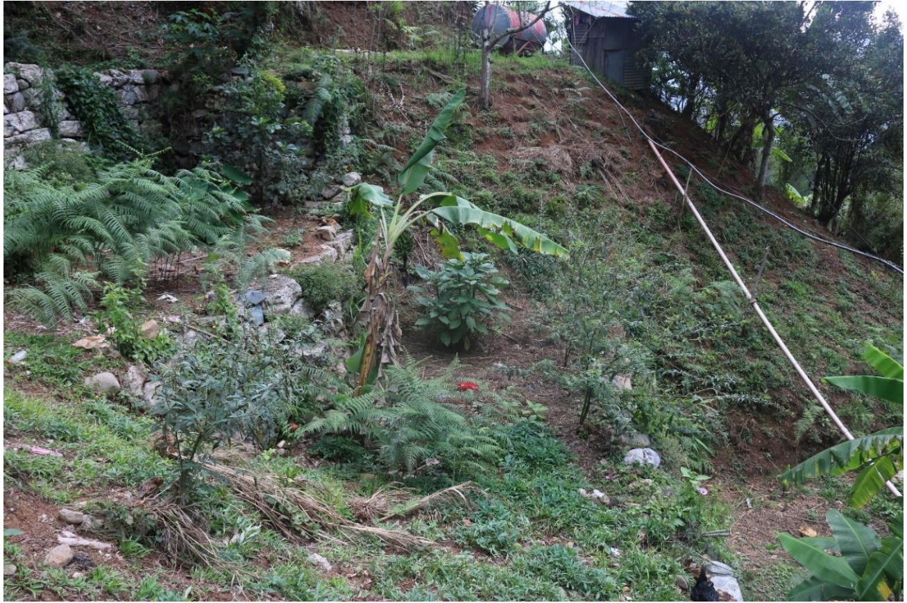
Figure 28. Pel-og , un creux de montagne renforcé par des terrasses consolidées par des pierres. Tekkong, mars 2020.
