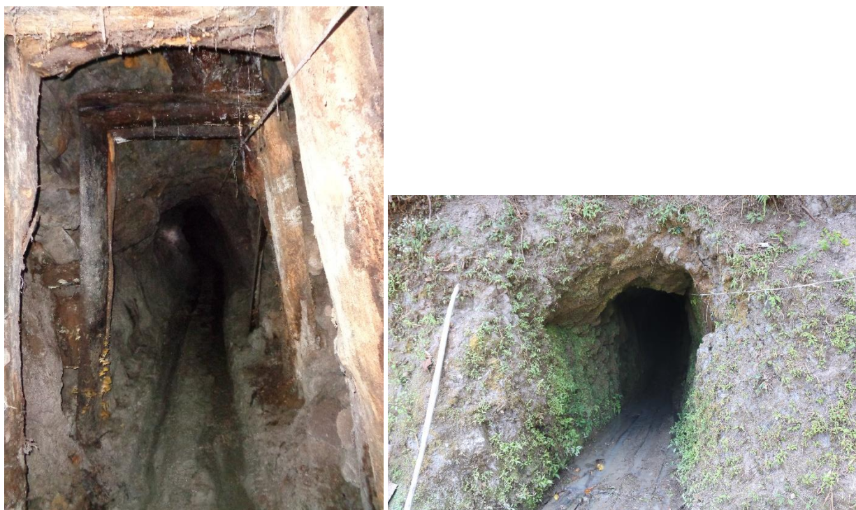
Figures 64 et 65. Entrée du ossok à Kalabkaben. Août 2016.
