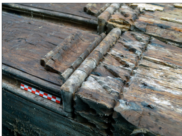
Détail des abouts décorés d'un sommier du premier étage et solives du plancher.
