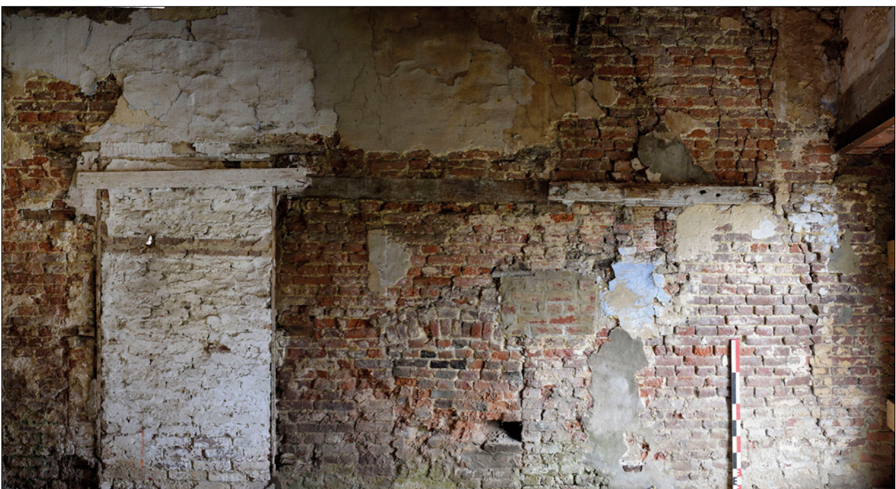
Vue du mur pignon du corps de logis depuis l'annexe. Au centre, la baie du fournil.
