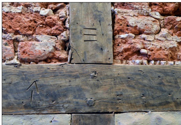
Détail des marques d'assemblages du pan-de-bois daté de 1730-1731.
