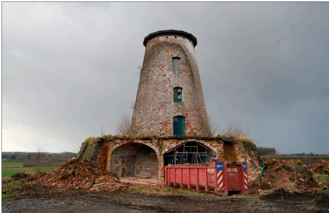
Saintes : le moulin de Hondzocht en cours de travaux.
