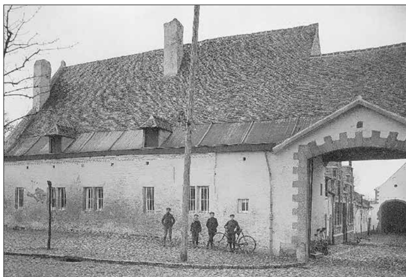
Nivelles : vue de l'entrée principale, depuis le Faubourg de Charleroi, du corps de la ferme al Saulch, avec en arrière-plan l'entrée désaxée de la grange (auteur inconnu ; https://monvieuxnivelles.jimdofree.com/rue-et-faubourg-de-charleroi , consulté le 25 mai 2023).
