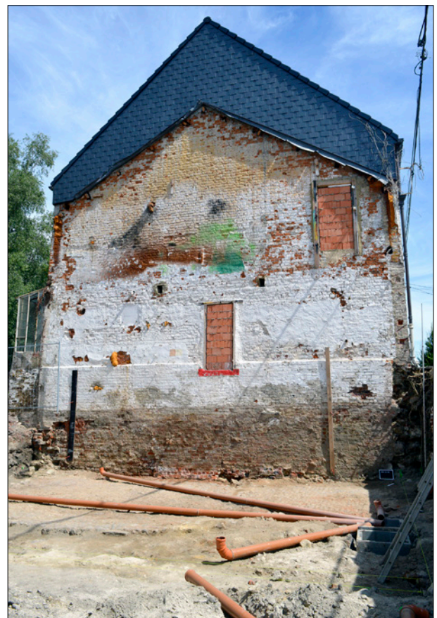
Vieux-Genappe : le pignon occidental de la maison sise au n° 94 de la rue de Bruxelles.
