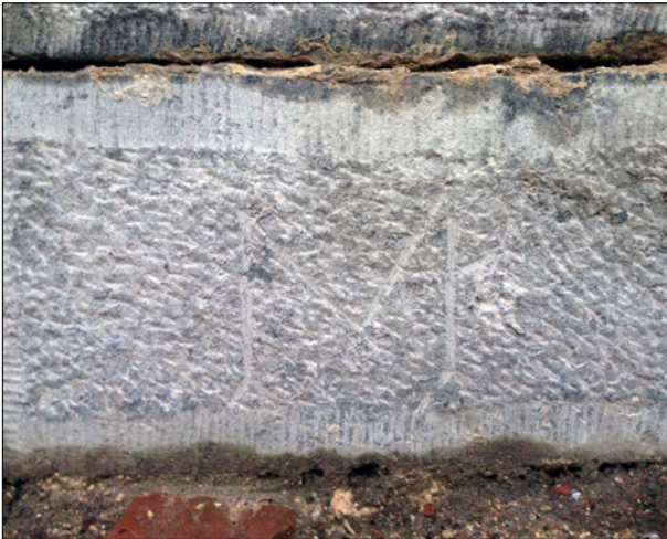
Marque de tâcheron de Mathias Paternotte sur le soubassement septentrional (7).
