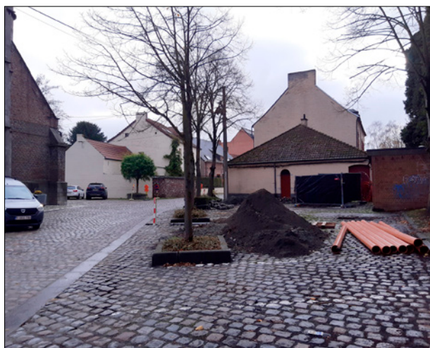
Boussu : vue générale du parvis de l'église Saint-Géry. La tranchée et le tas contenant les ossements se situent à l'arrière-plan, à droite, derrière une grille bâchée.
