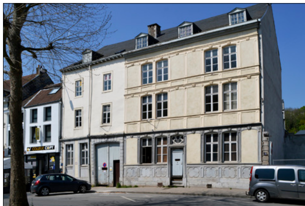
Verviers : l'ancien orphelinat des filles, façade rue du Collège.
