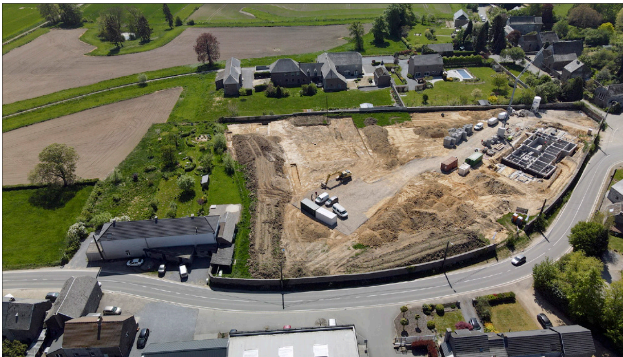
Ohey : vue aérienne du site en cours de destruction (photo P.-M. Warnier, SPW-TLPE, Direction de la gestion des informations territoriales).
