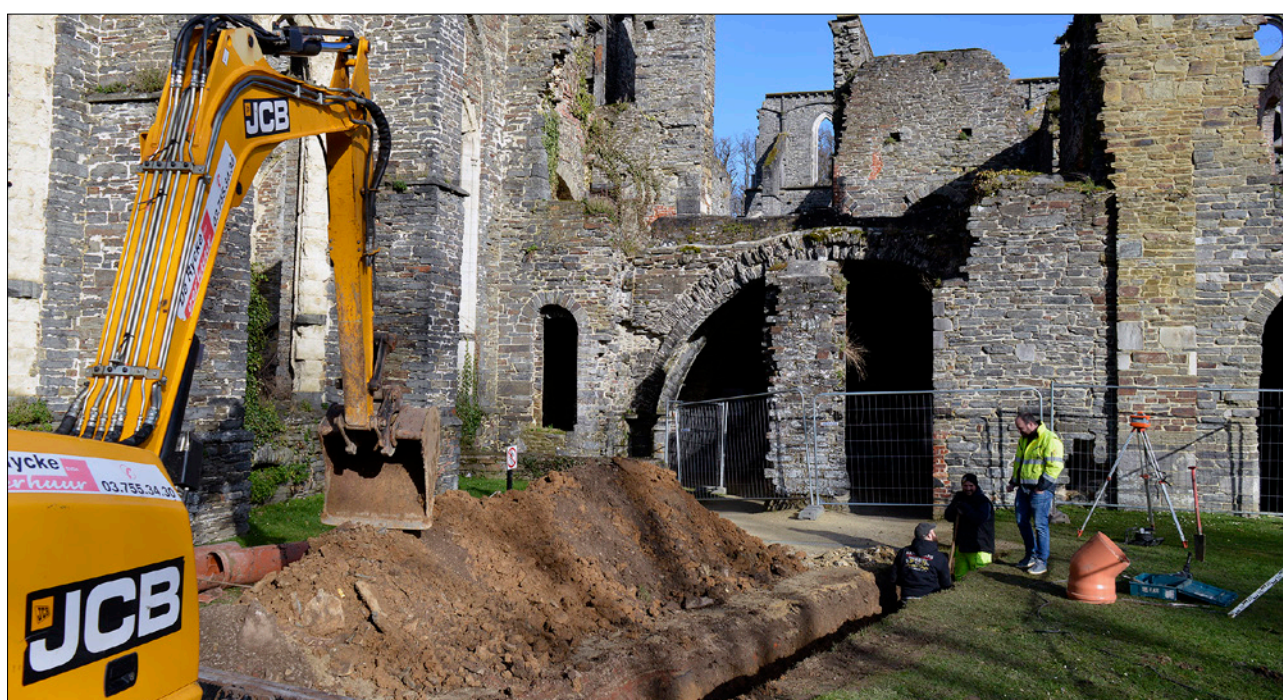
Villers-la-Ville : vue générale des terrassements dans l'enclos abbatial.
