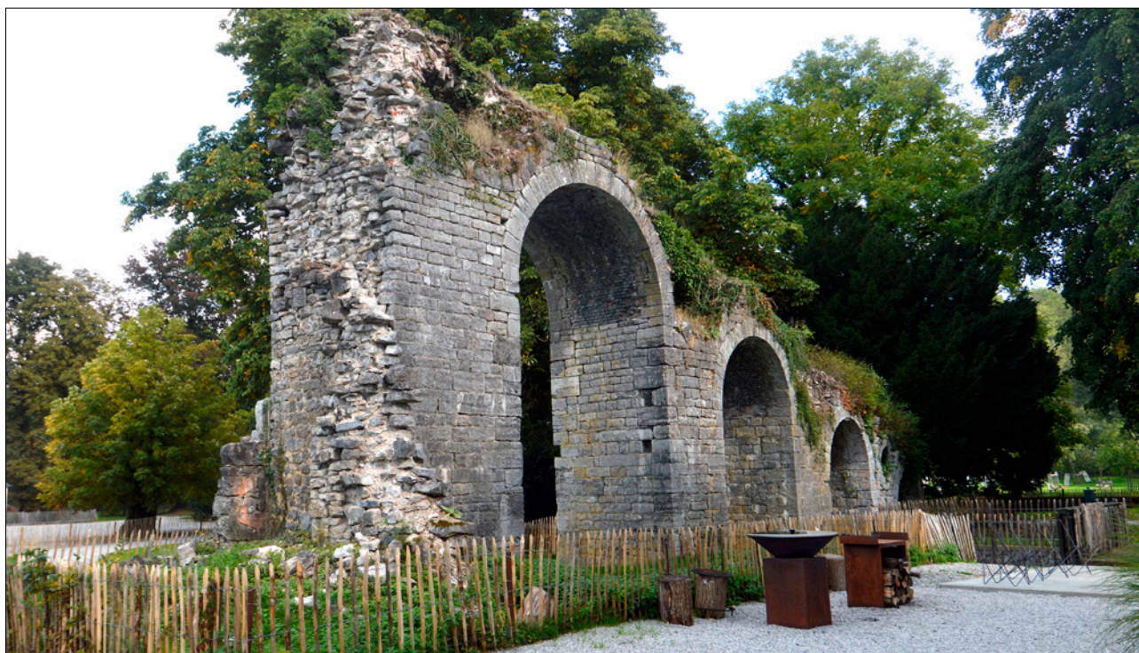
Couvin, domaine Saint-Roch : le côté sud du monte-charge.
