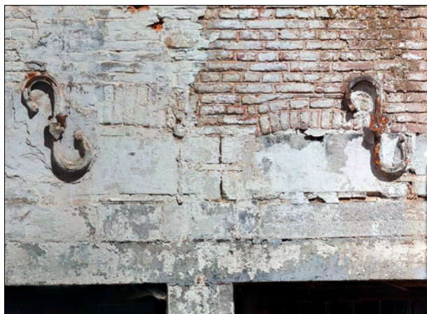
Détail d'une des ancrs de la façade arrière.
