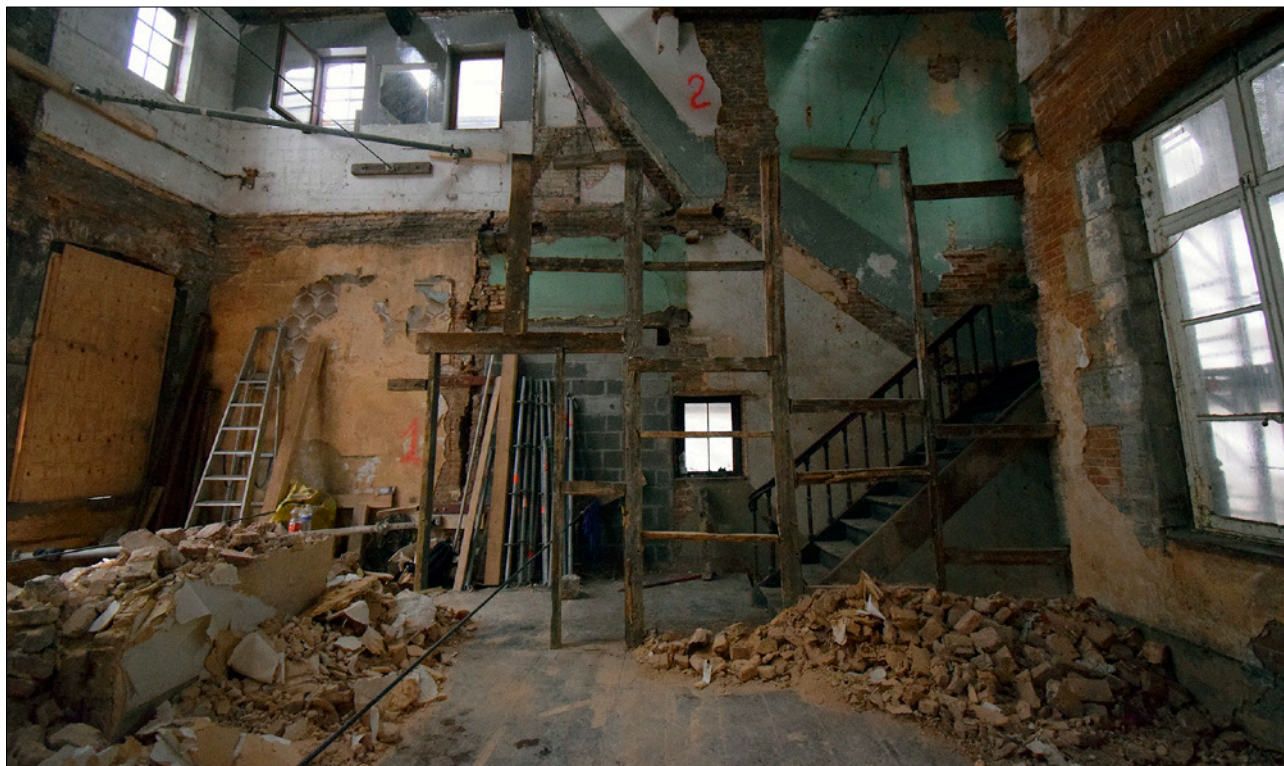
Le pan-de-bois du mur de refend de l'étage en cours de démontage.
