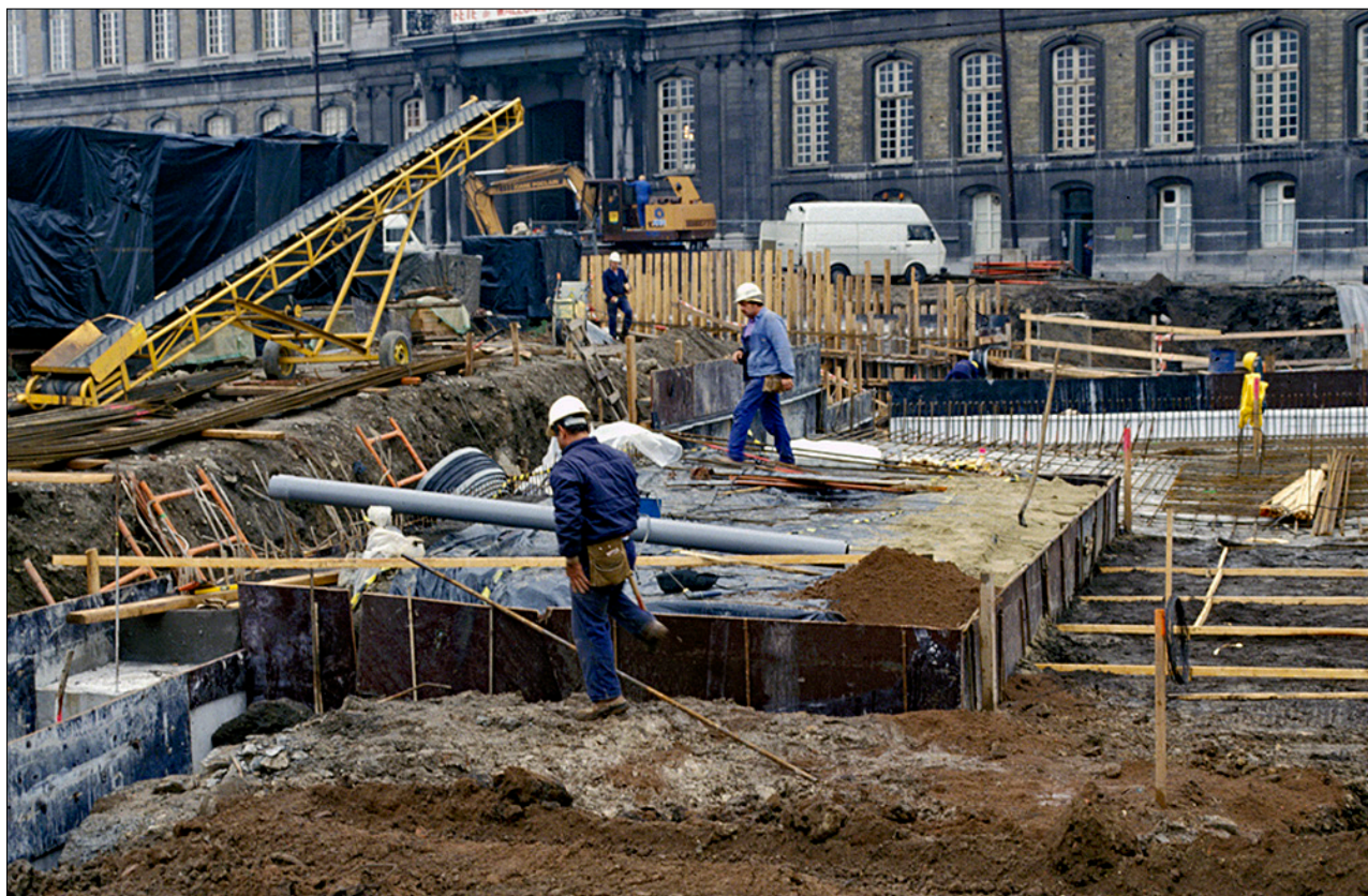
Coffrage d'une réserve archéologique avant bétonnage de la dalle de la place Saint-Lambert (1993).
