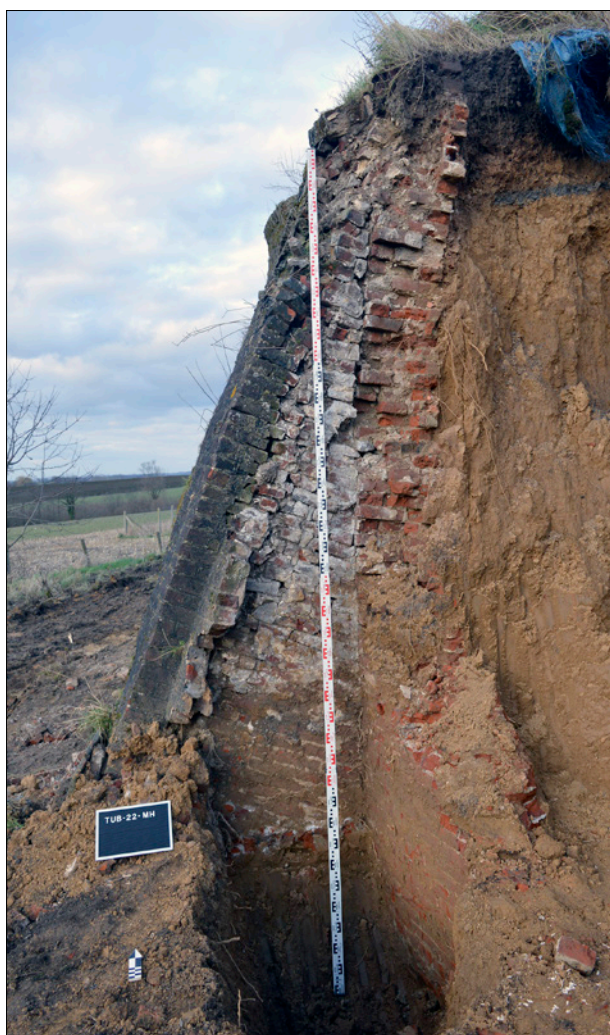
Vue vers le nord du moulin en cours de démolition. On y voit de droite à gauche l'épais remblai entre la tour du moulin et la passerelle, le premier mur de celle-ci et un des contreforts du second mur appuyé sur un muret.
