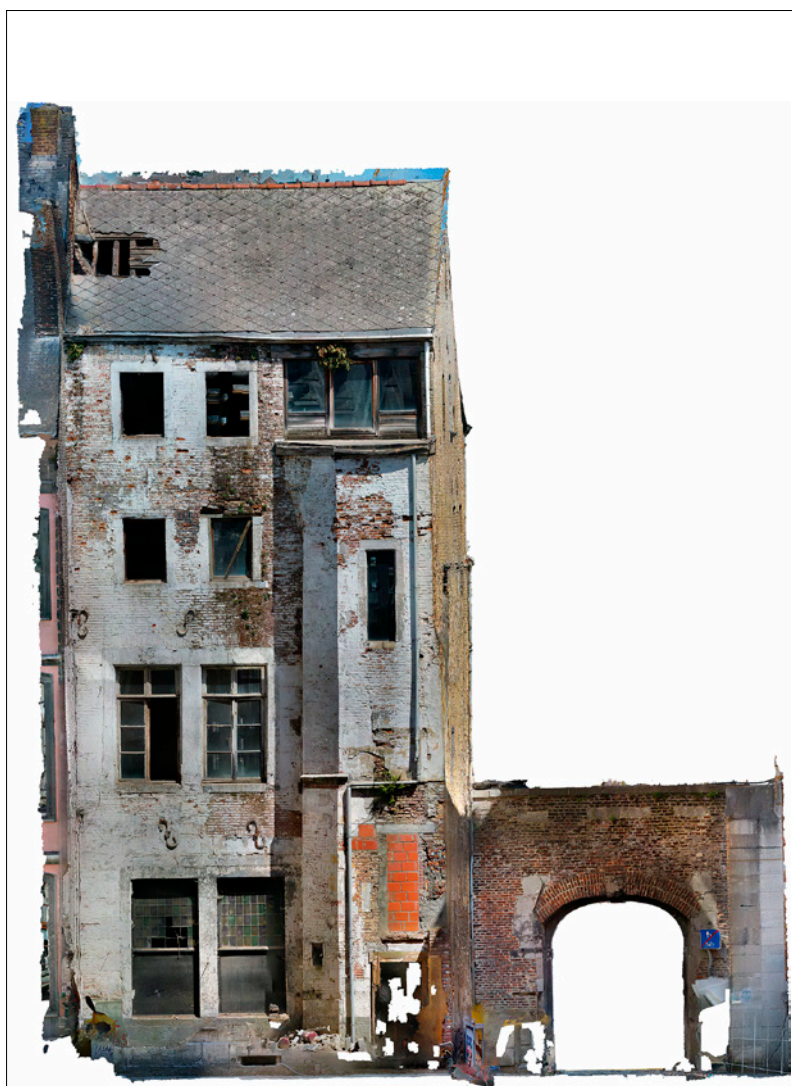
Photogrammétrie de la façade arrière de la maison Gaiffier (P.-M. Warnier et J.-C. Sainte, SPW-TLPE, Digit).
