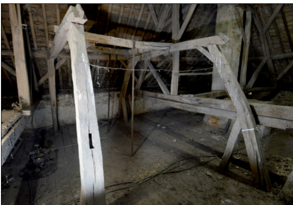
Aublain : vestiges vraisemblables de la charpente primitive du presbytère.
