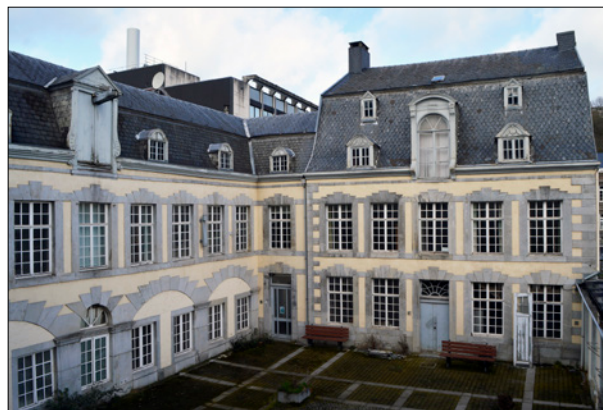
Édifices bordant la cour intérieure.
