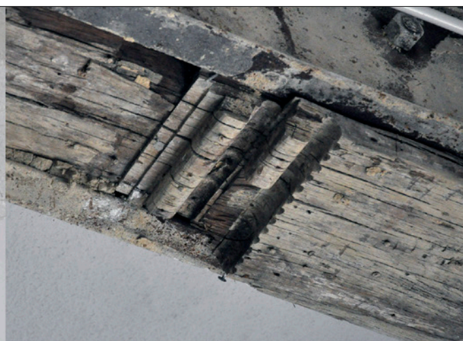
Détail d'une semelle de poutre de la salle de musique (aile est du cloître) datée de 1585-1586d (à gauche) et détail d'une semelle de poutre de l'aile sud du cloître (premier étage) avec un décor dentelé (à droite) (© MRAH, 2023).
