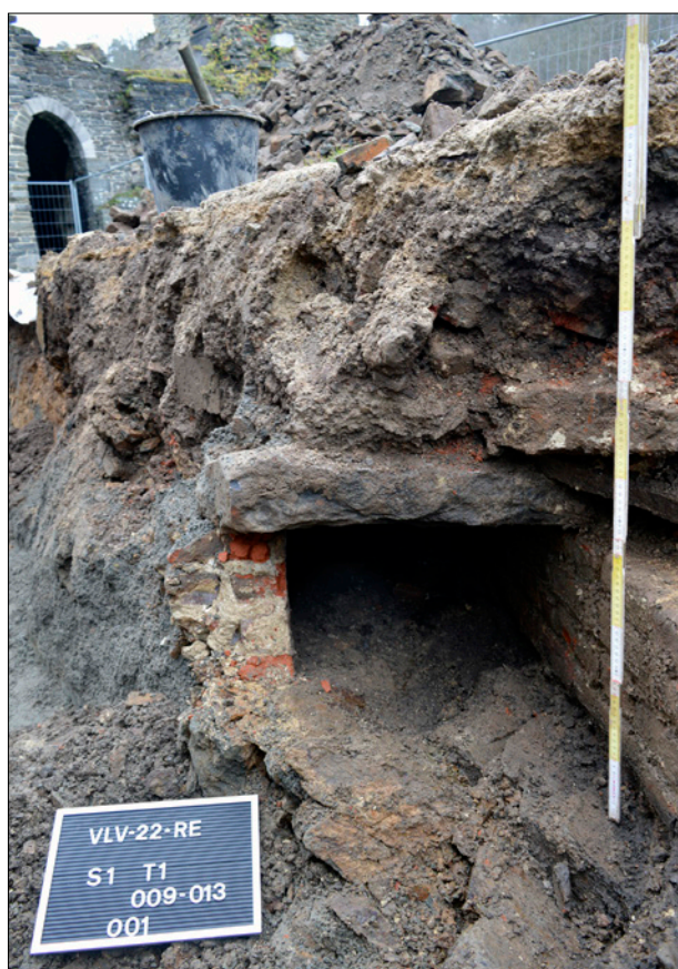
Le chenal d'évacuation.
