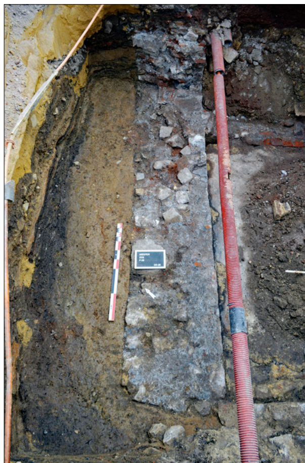
Liège, suivi sur le tracé du tram : vue générale du fond du terrassement pour la chambre de visite.
