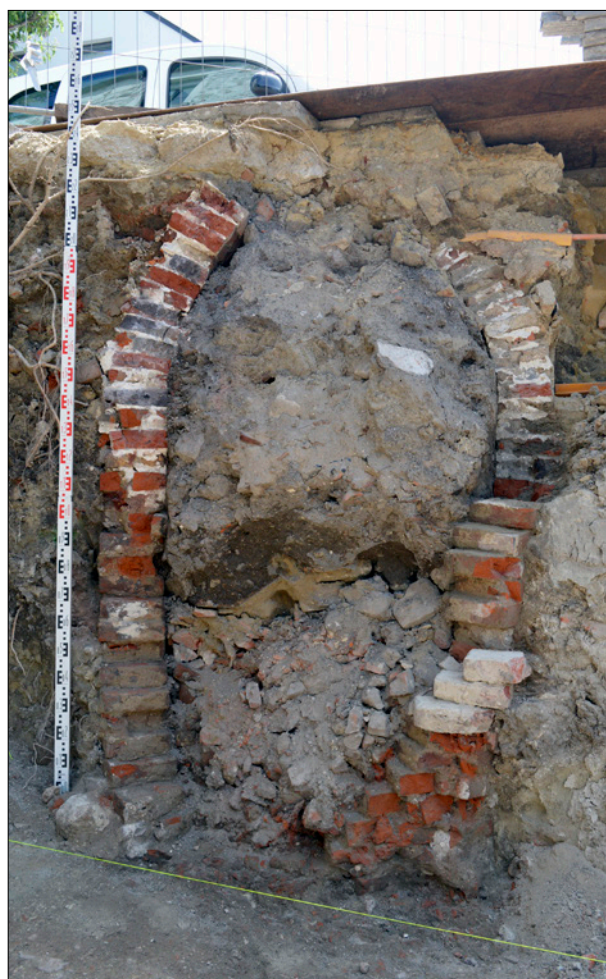
Puits ou citerne visible dans la coupe à l'aplomb du trottoir.
