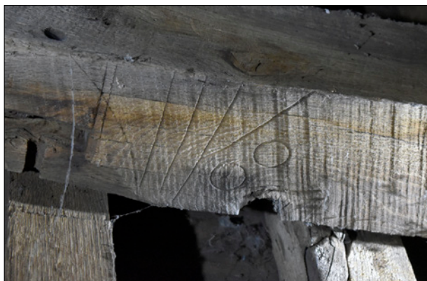
Marque réalisée à la rainette (III OO avec contre-marque en langue de vipère) et apposée sur une des croix de saint André de la charpente (1534/1535d) de l'église (© MRAH, 2023).
