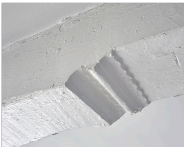
Détail d'une semelle de poutre de la salle de musique (aile est du cloître) datée de 1585-1586d (à gauche) et détail d'une semelle de poutre de l'aile sud du cloître (premier étage) avec un décor dentelé (à droite) (© MRAH, 2023).
