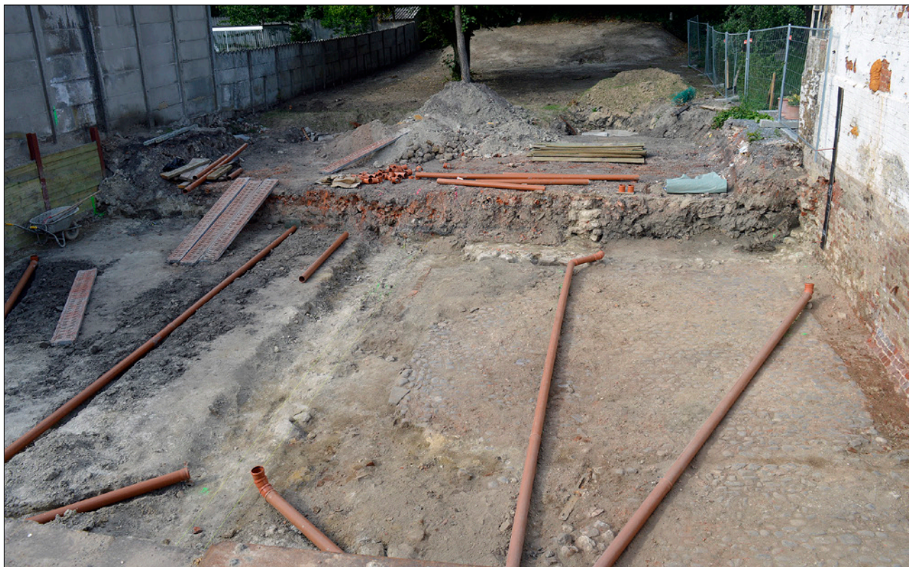
Vue vers le nord du terrassement.
