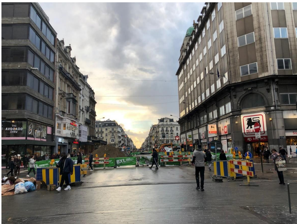
Fig.8 : AN1 – prise de vue systématique vers le sud.
