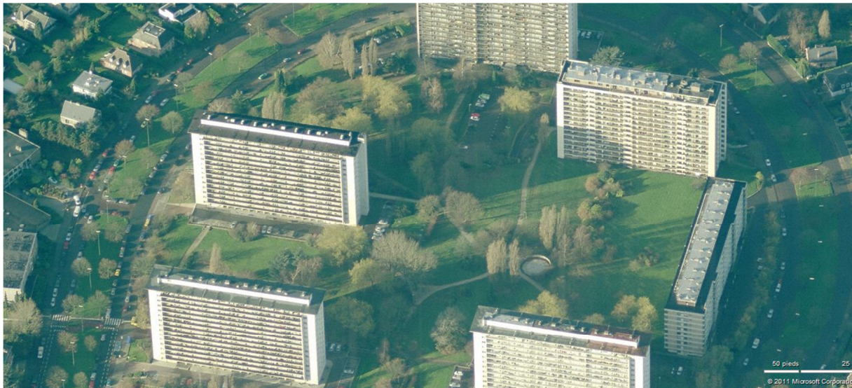
Figure 60 : Photo aérienne de « Mutsaard » 218
