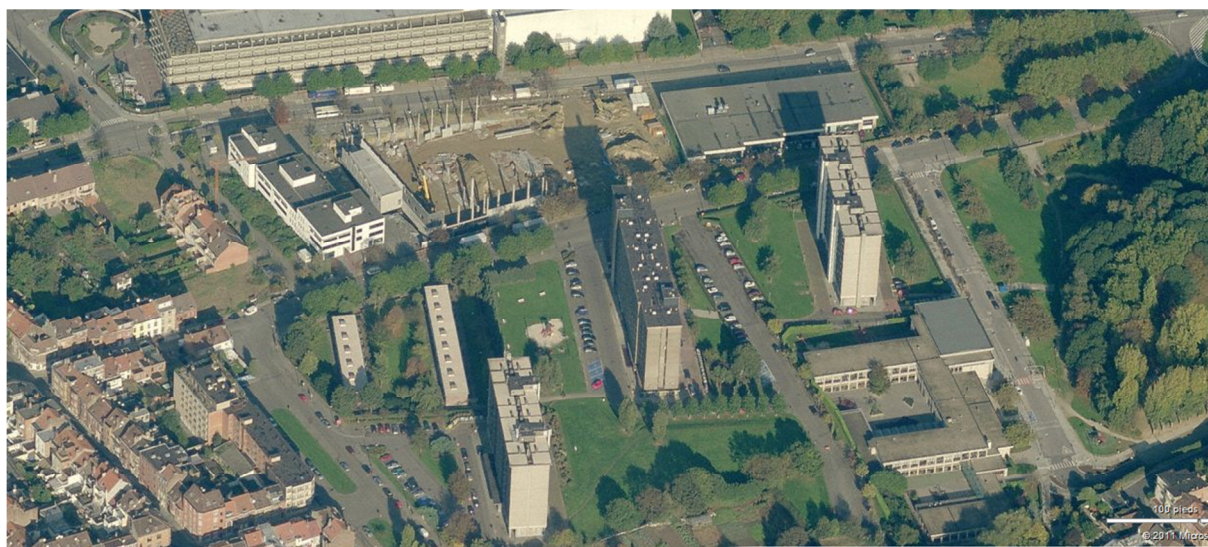
Figure 55 : Photo aérienne de «Ieder zijn huis – Stroobants» 213
