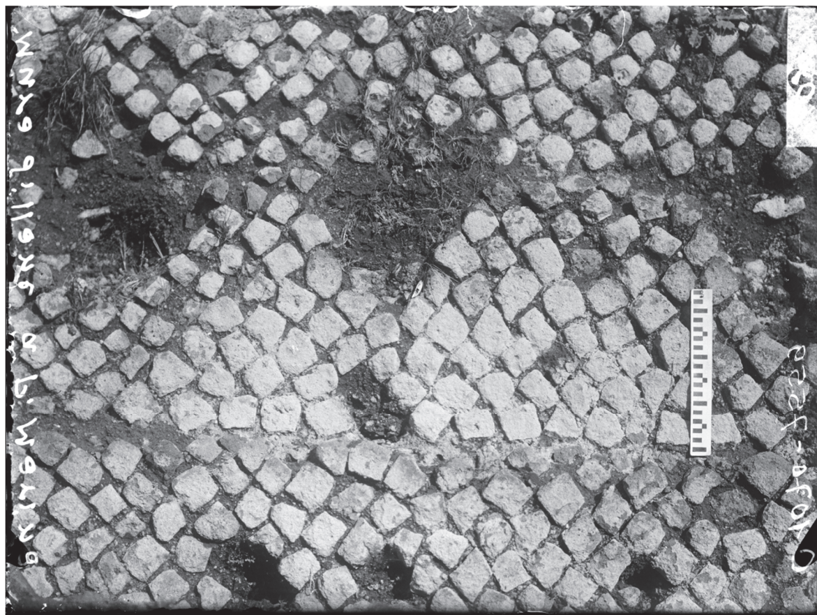
Muraille tardo-républicaine : détail du parement extérieur à proximité de la Porta Marina (tronçon XX ?). (PAOANT, Archivio Fotografico , C 1070).
