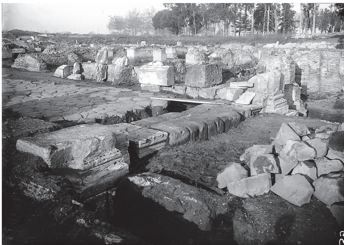
2. Porta Secundaria en décembre 1912. Vue du sud-est. (PAOANT, Archivio Fotografico , B 1941).
