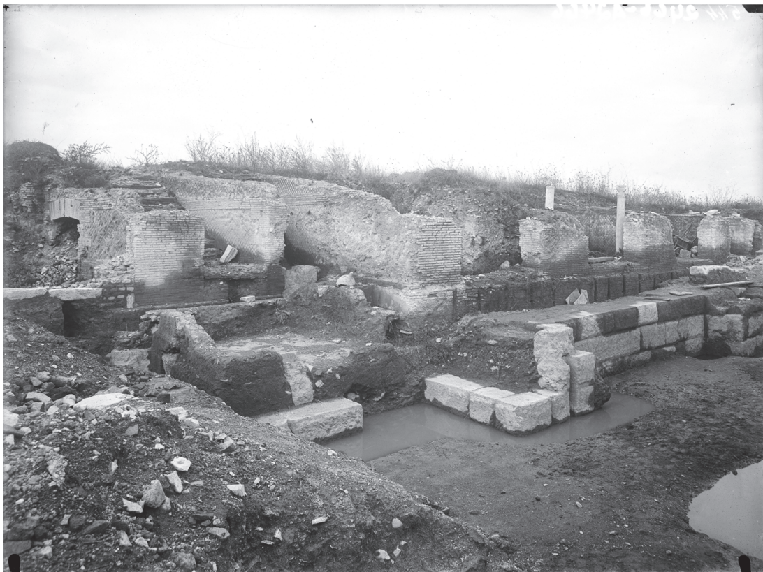
1. Porta Marina (jambage nord), édifice III, VII, 1 et Domus del Ninfeo . Vue du sud-ouest. (PAOANT, Archivio Fotografico , A 2466).
