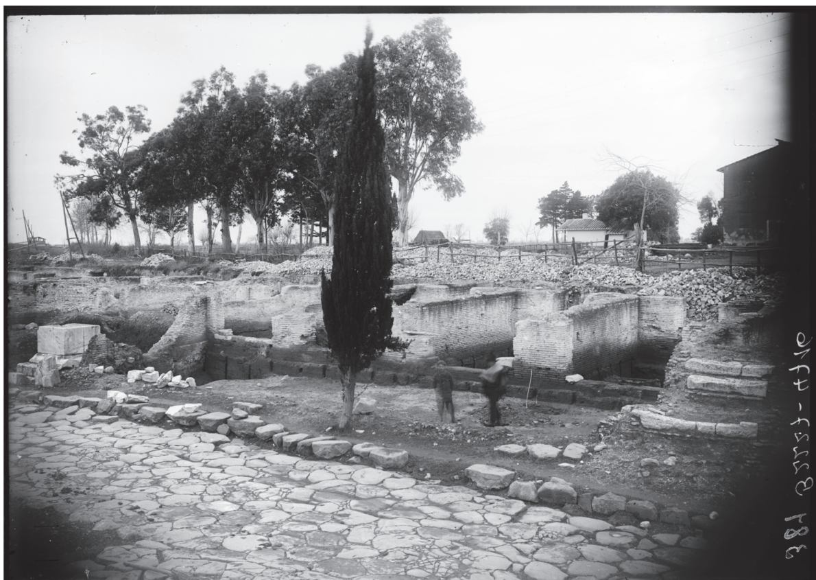
1. Partie ouest du Caseggiato a taberne (PR, D5) vers 1919. Vue du sud-est. (PAOANT, Archivio Fotografico , B 2227).
