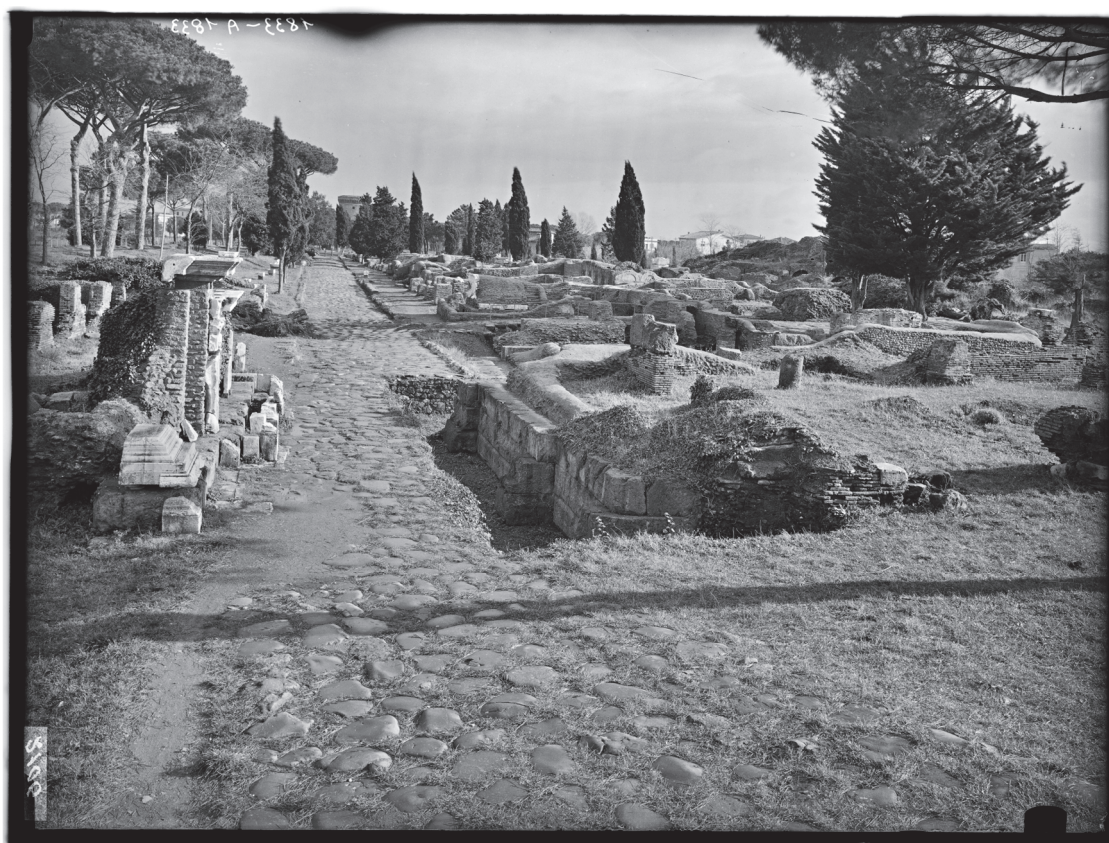
1. Porta Romana . Vue de l'ouest. (PAOANT, Archivio Fotografico , A 1833).
