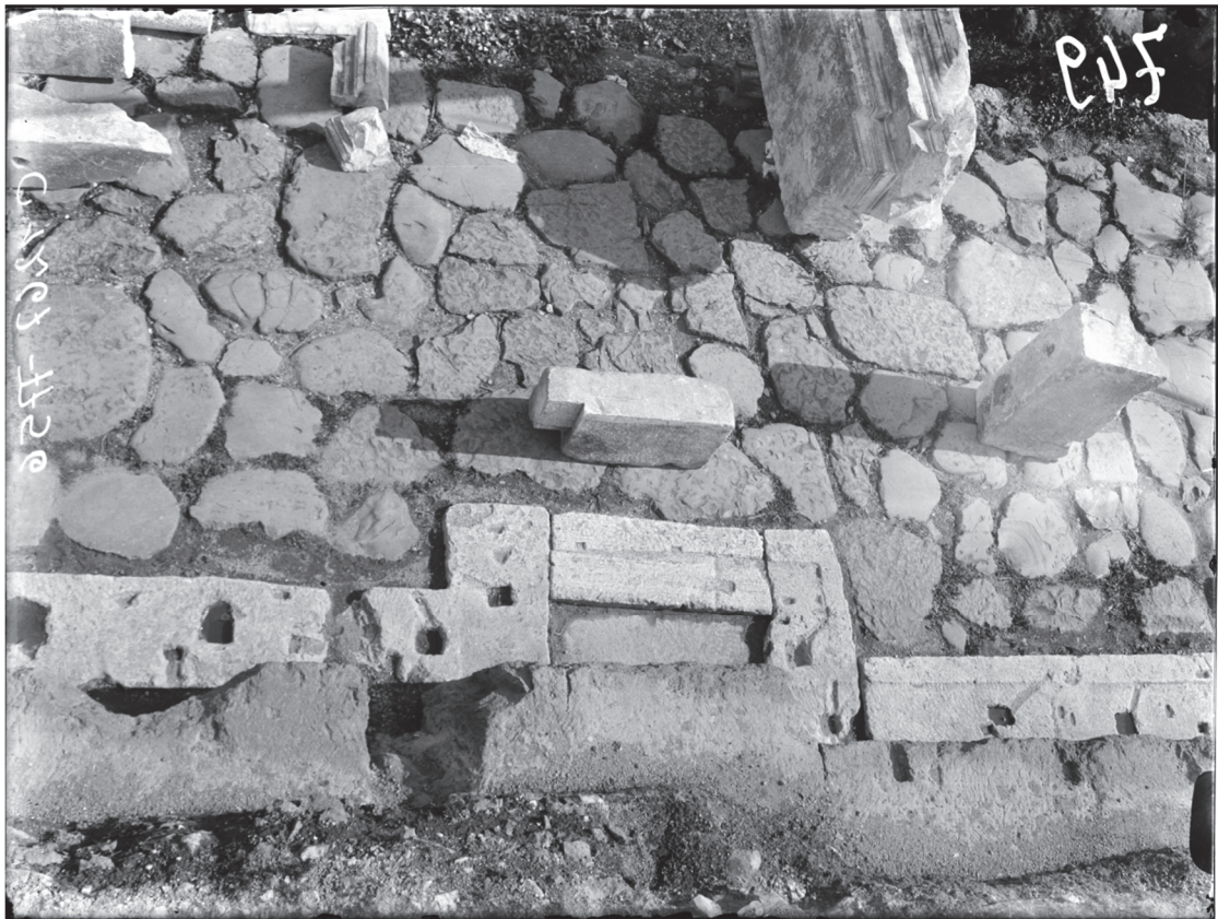
1. Porta Romana , jambage nord : blocs de travertin formant la deuxième phase de la porte. (PAOANT, Archivio Fotografico , C 1267).
