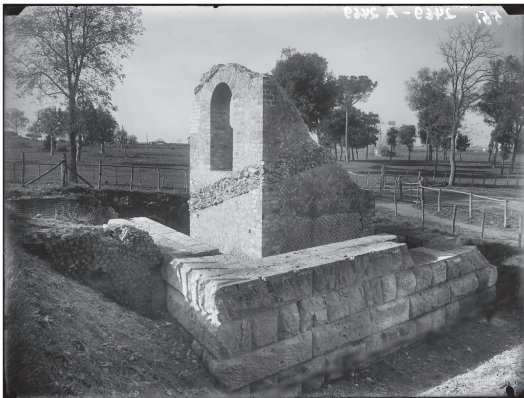
1. Enceinte tardo-républicaine : tour carrée sur la rive du Tibre (Propriété Aldobrandini). Vers 1923. ( PAOANT, Archivio Fotografico, A 2469 ).
