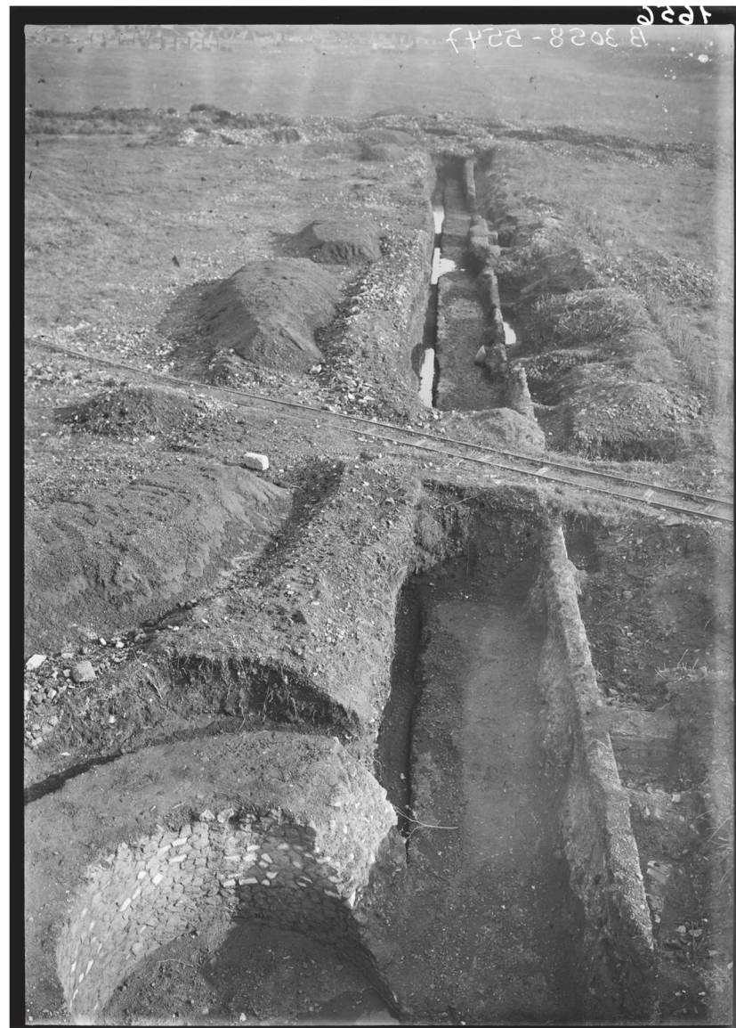
2. Enceinte tardo-républicaine, région IV : tronçon situé à l'est de la tour circulaire sud-ouest. (PAOANT, Archivio Fotografico , B 3058).
