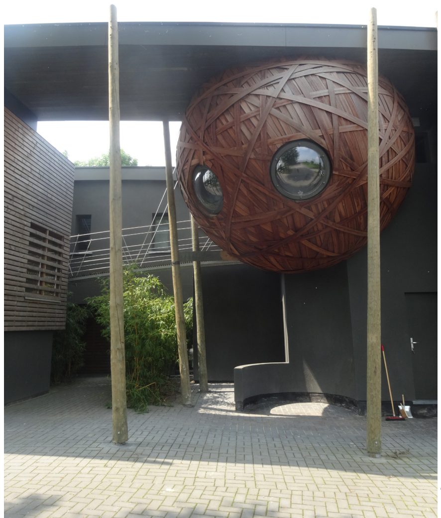
Photo de 36°8 - Chambre d'amis de l'habitat groupé Pic au Vent
