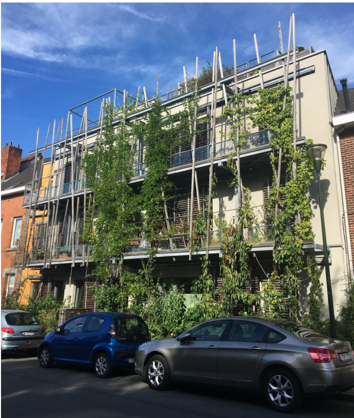
Photo de BxlECO - Façade de l'habitat groupé Biplan
