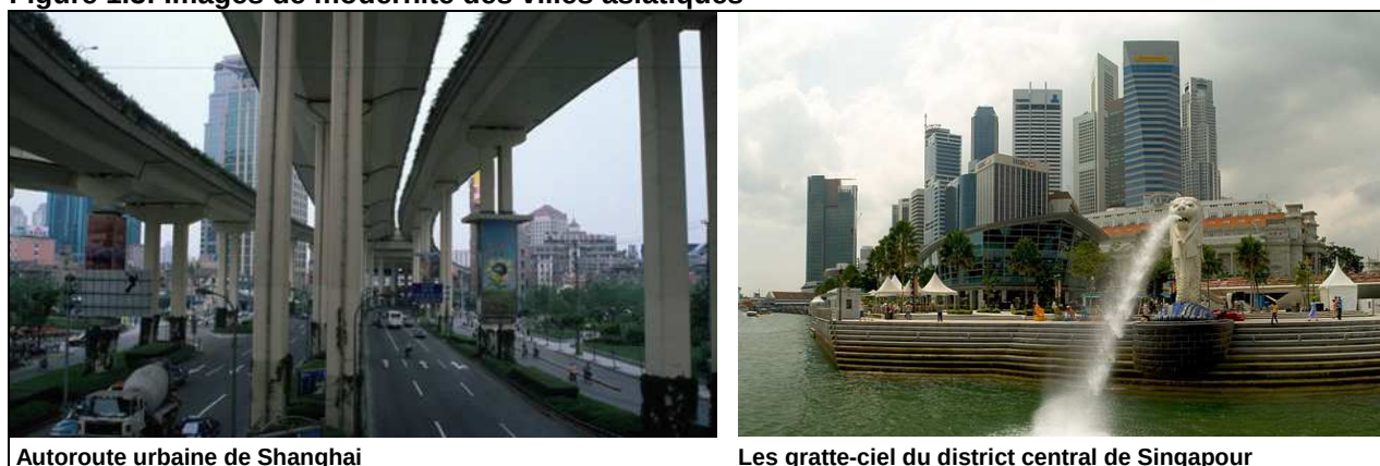
Autoroute urbaine de Shanghai
