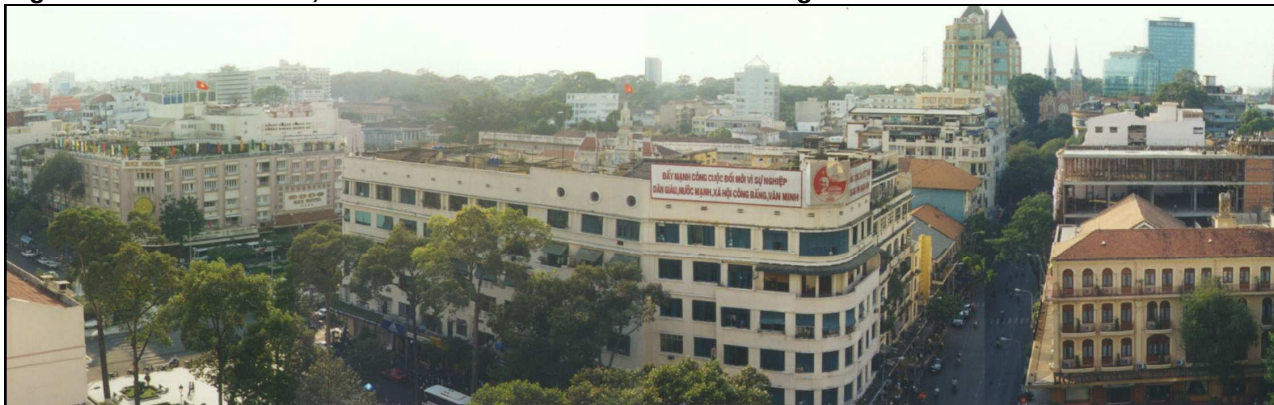
Figure 1.12: Le district 1, croisement entre la rue Le Loi et Dong Khoi
