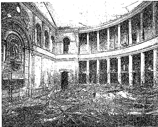
In 1883 werd de Kamer geteisterd door een zware brand die het halfronde en de bibliotheek volledig in as legde. Het onderzoek dat de kamerinstanties na de feiten voerden wees uiteindelijk een defect verwarmingstoestel in het dak van de plenaire zaal, een zgn. sunburner, als oorzaak aan.
