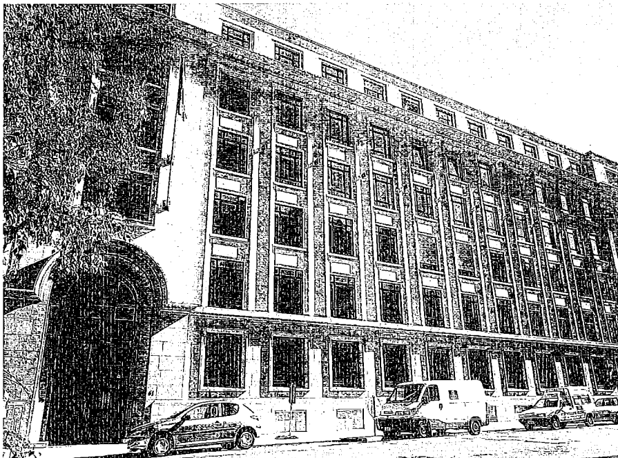
In 2002 betrokken de Quaeastuurdiensten een totaal vernieuwd gebouw aan de Hertogstraat tegenover het Paleis der Natie. Dit vormt mede het bewijs dat het parlementaire werk ingebed wordt in een steeds groter ondersteunend kader.
