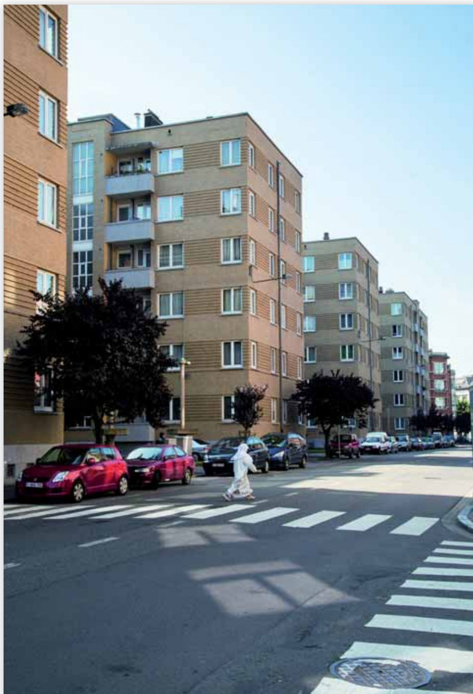
Logements sociaux de la Maison liégeoise (rue Louis Jamme), Melchior Jeurgen architecte, 1937-1939 - Etat actuel (après remplacement des châssis). © Elodie Leduc pour la FWB
