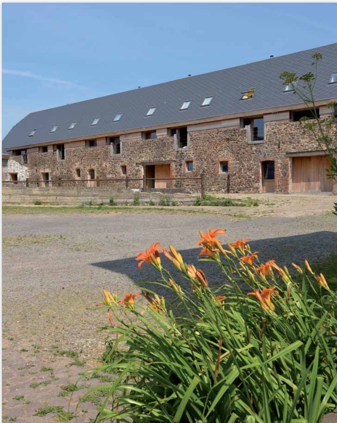
Ferme de la Forestaille à Lobbes rénovée et transformée en logements par le Fonds du Logement de Wallonie. © F. Dor SPW DG04
