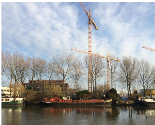
Début des travaux du complexe immobilier Nautilus à Anderlecht (février 2017), à proximité directe de la concession de DHAFF.
