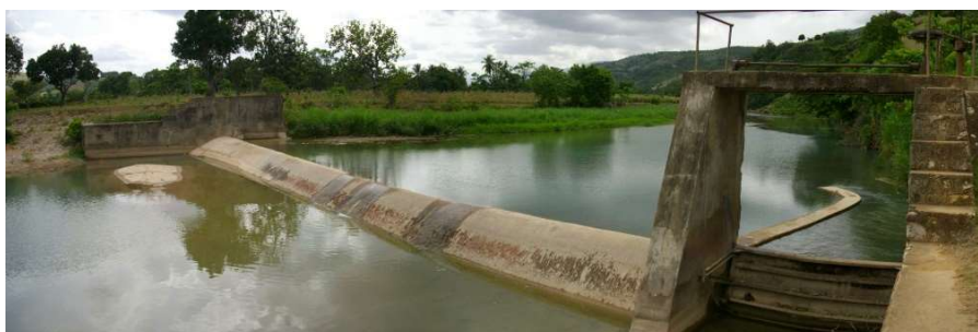
Figure I-14. Déversoir de Dory
