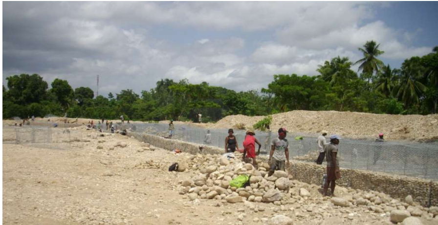
Figure I-7. Mur en gabions protégeant la ville de Maniche des débordements de la rivière Cavaillon
