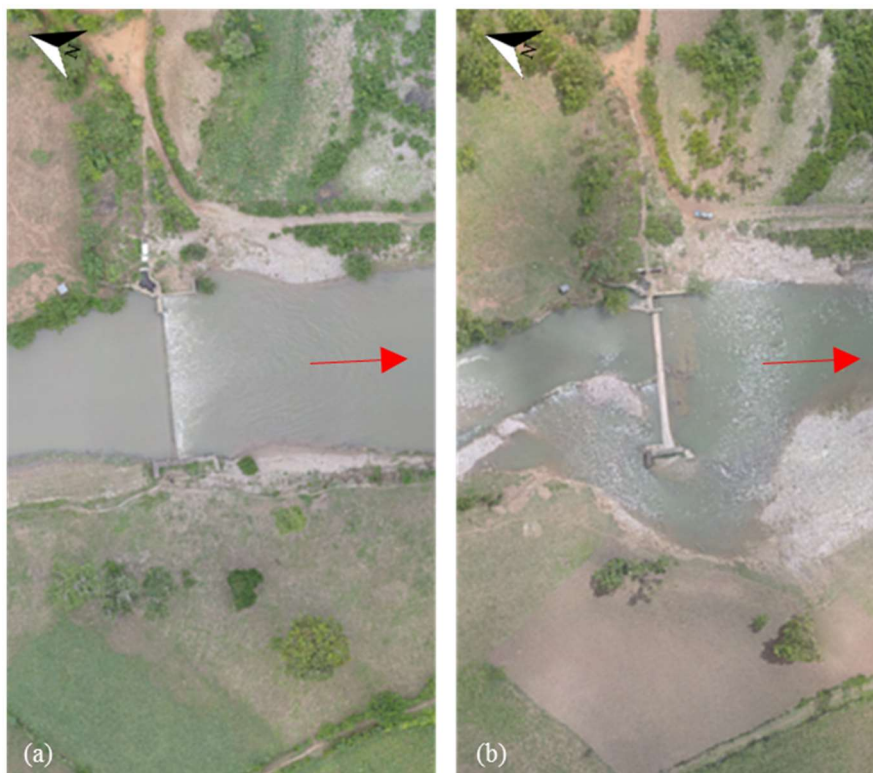
Figure 4-9. Vue aérienne du déversoir de Dory (a) en mai 2016 (b) en mai 2017
