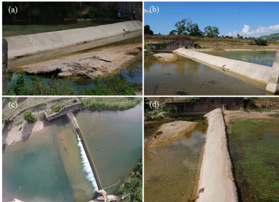
Figure 3-21. Illustrations du déversoir (a) vue aval depuis la rive droite (b) vue aval depuis la rive gauche (c) vue depuis un drone (d) vue de la crête depuis la gauche du déversoir
